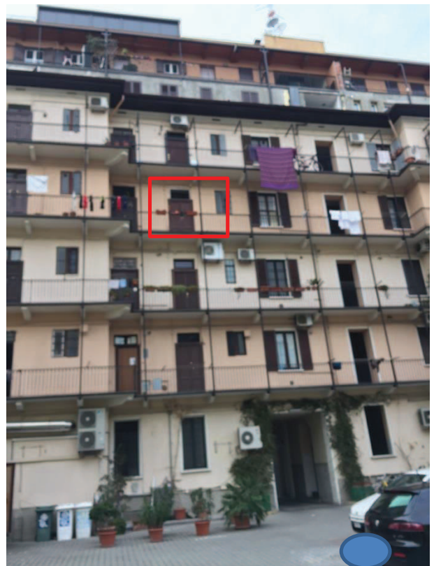
Vista facciata interna su cortile
