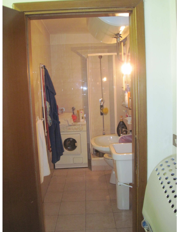
locale cantina trasformato senza autorizzazione a bagno
