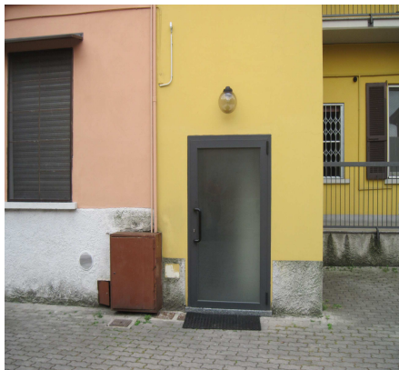
ingresso al piano cantinato
