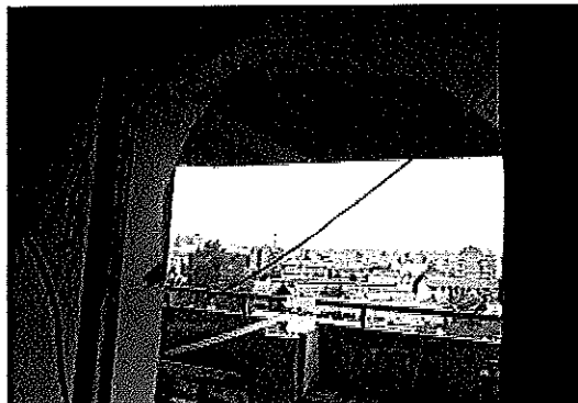
Porta-finestra con vetro rotto
