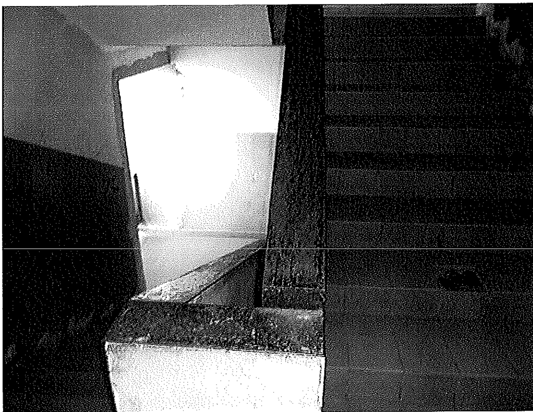
Vano scale comune
