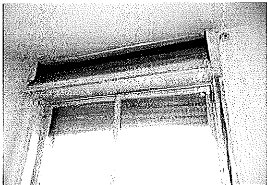
Serramento tipo – cassonetto avvolg. rotto
