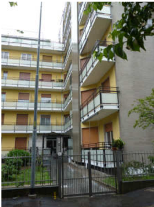
FOTO 2 –Ingresso pedonale al civico n° 1 di Via Paolo Goglio
