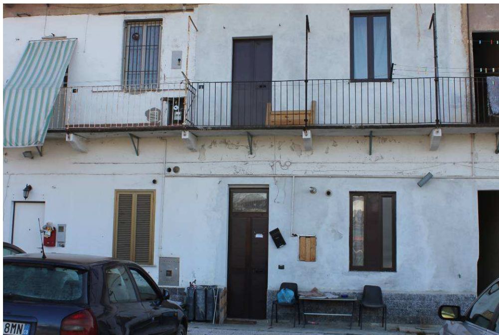
FOTO 3: CESATE, VIA GIUSEPPE VERDI N. 3, Vista u.i. da corte interna
