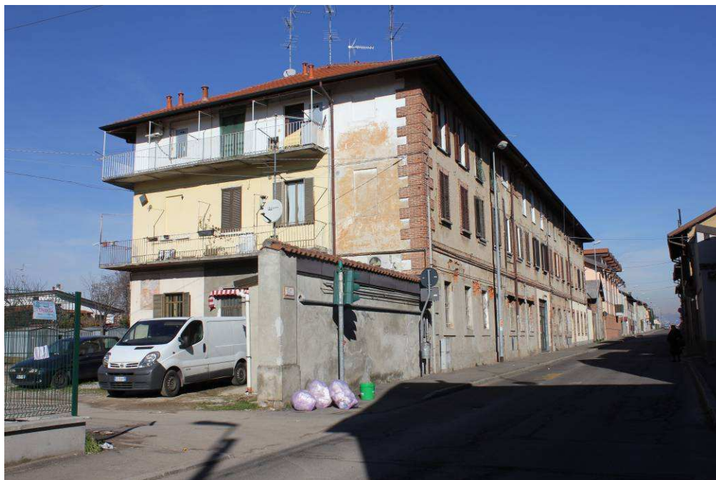
FOTO 1: CESATE, VIA GIUSEPPE VERDI N. 3, Vista fabbricato
