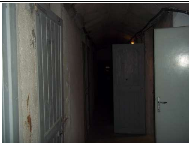
Corridoio sottotetto e porta di accesso al sottotetto pertinenziale dell'appartamento
