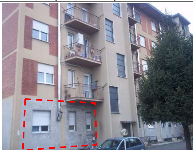
Finestre dell'appartamento con affaccio sul cortile interno
