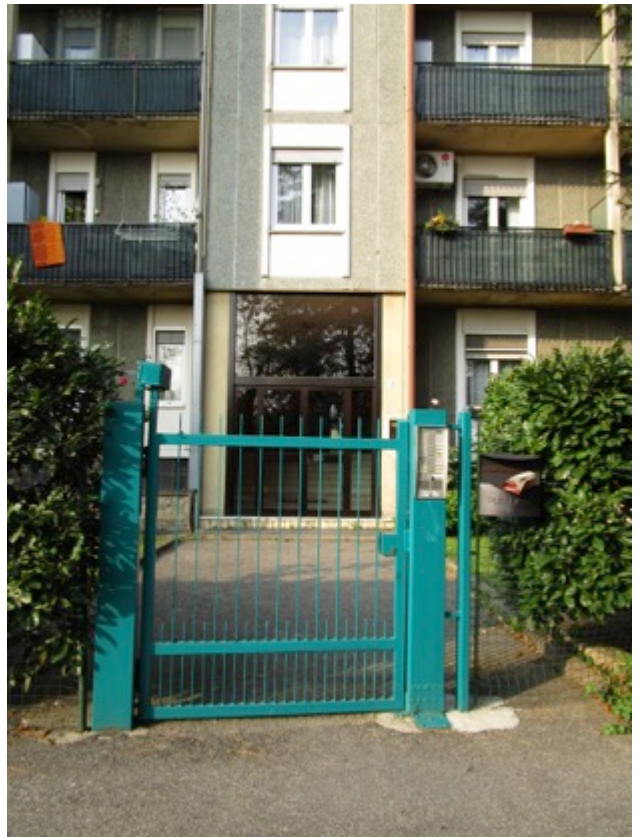
4. Accesso pedonale, civico 13.
