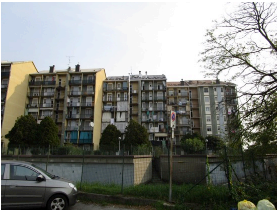
7. Complesso condominiale, vista lato ovest.
