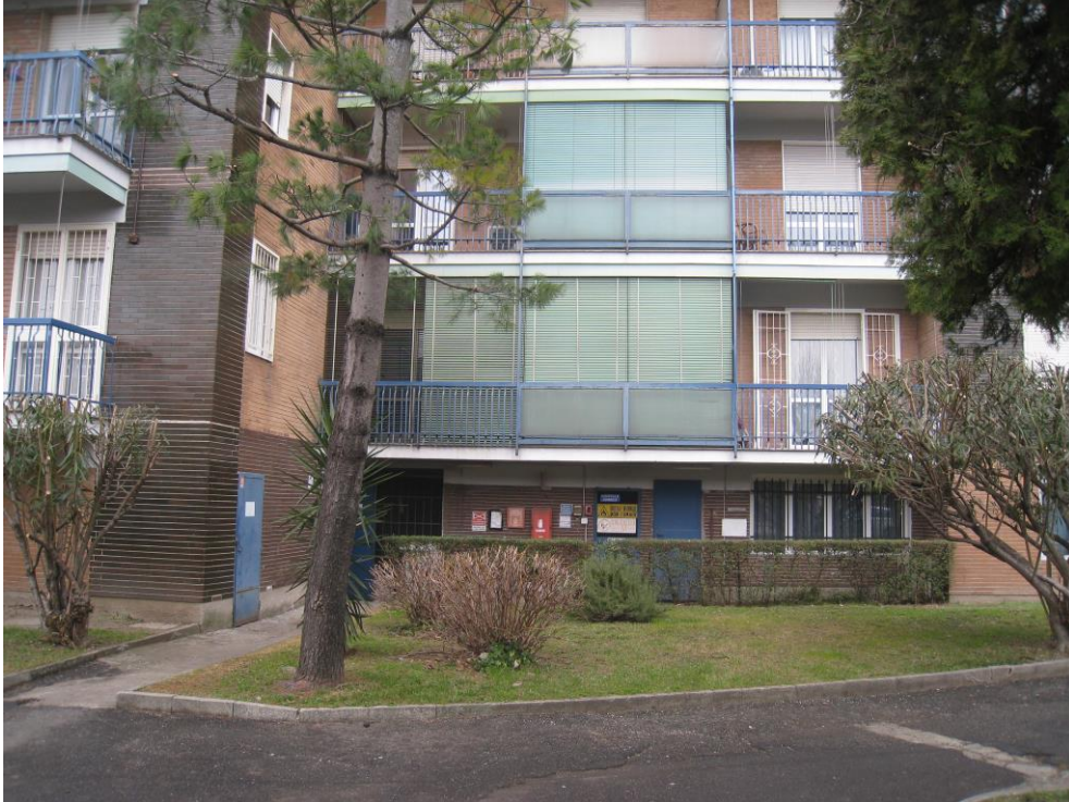
Vista del balcone dell'unità immobiliare al primo piano (verso strada)
