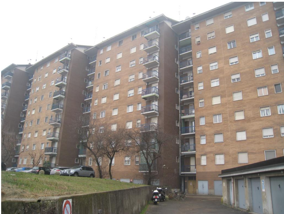
Vista della facciata verso cortile
