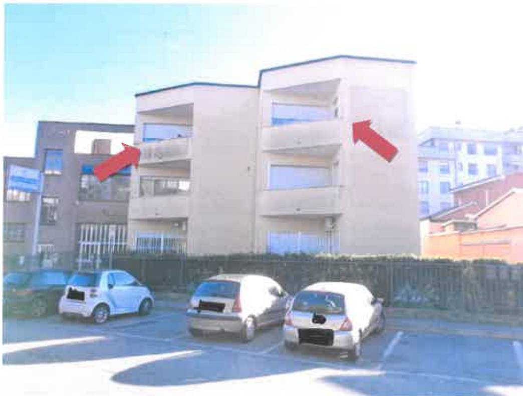
- FOTO 2 - FACCIATA NORD-OVEST - VIA FRATELLI CERVI - IN EVIDENZA I BALCONI DELL'APPARTAMENTO -
