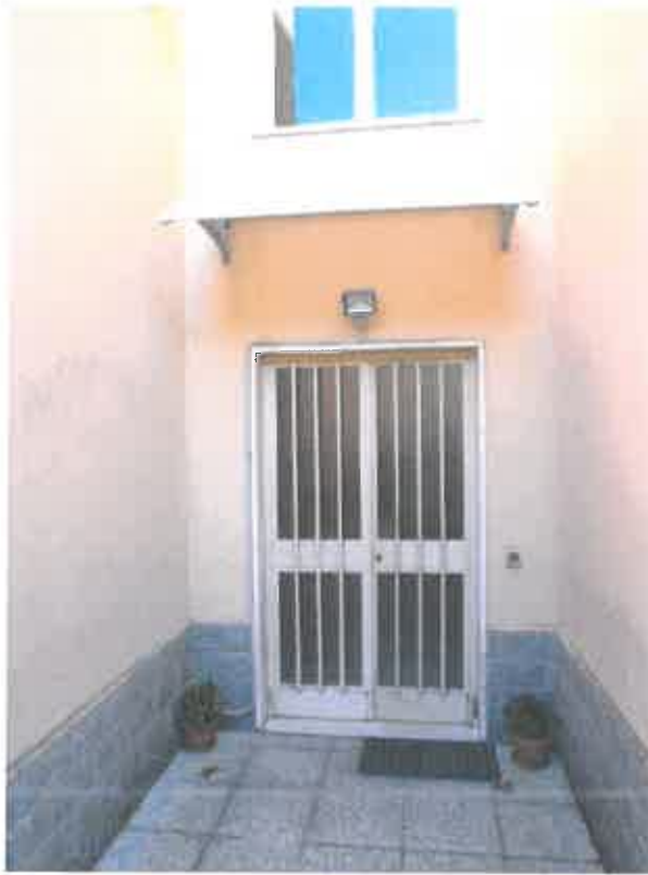
- FOTO 3 - INGRESSO CONDOMINIALE -
