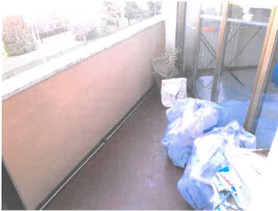
- FOTO 11 - BALCONE ACCESSIBILE DA CUCINA E SOGGIORNO -
