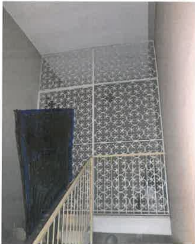
- FOTO 4 - PARTICOLARE CHIUSURA PIANEROTTOLO -
