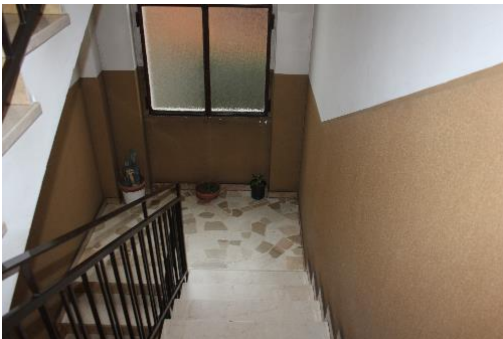
FOTO 3: BAREGGIO (MI), VIA G. CESARE 2, scale condominiali
