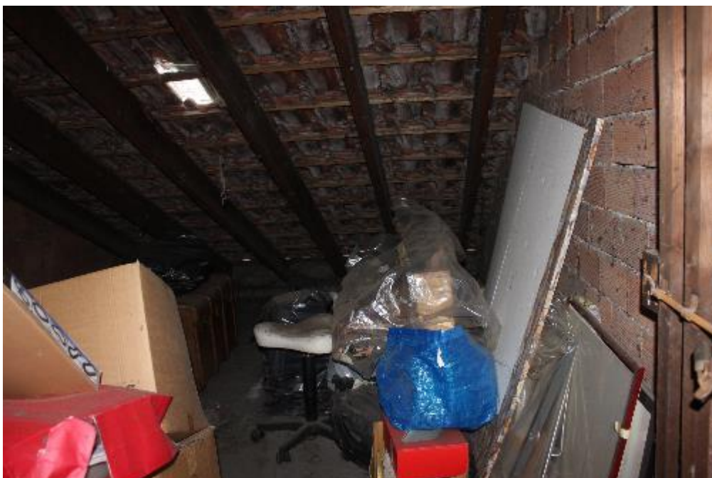
FOTO 15: BAREGGIO (MI), VIA G. CESARE 2, solaio
