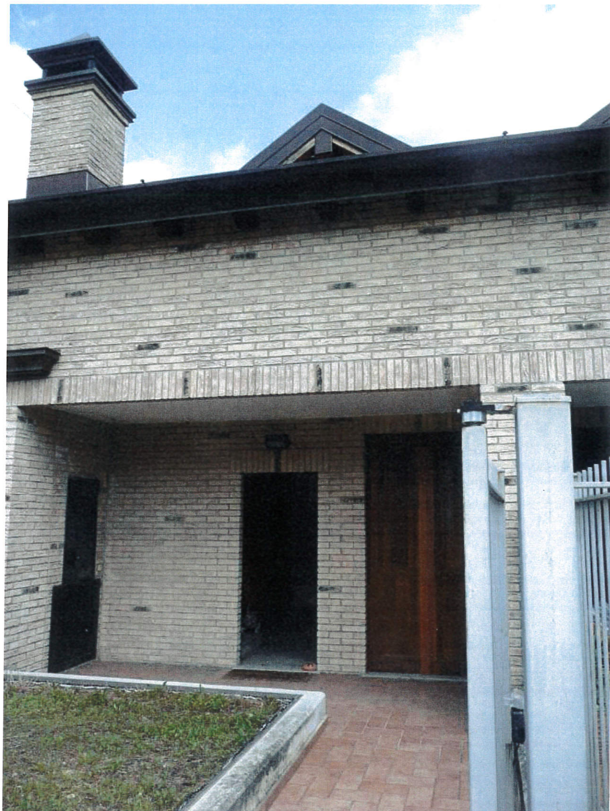
FACCIATA SU GIARDINO INTERNO
