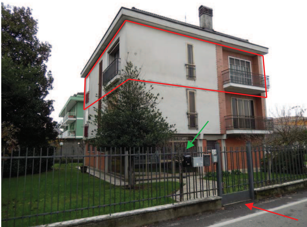
FOTO 2: Ulteriore vista, dalla strada, del fabbricato in cui è sita l'unità pignorata, la cui posizione, che occupa l'intero secondo piano, è evidenziata con il poligono rosso. La freccia rossa indica l'ingresso pedonale, quella verde l'ingresso all'edificio.
