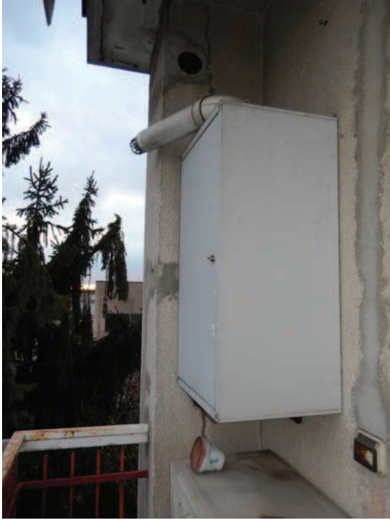
FOTO 22 e 23: Esterno dell'unità pignorata – Viste di dettaglio della caldaia murale a gas ubicata all'esterno, nel balcone 2.
