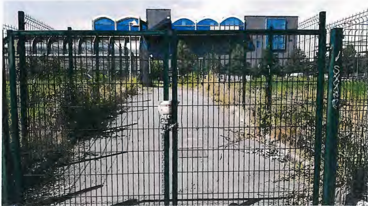
Chiusura accesso carraio (verso sottopasso ferroviario) con catena e lucchetto
