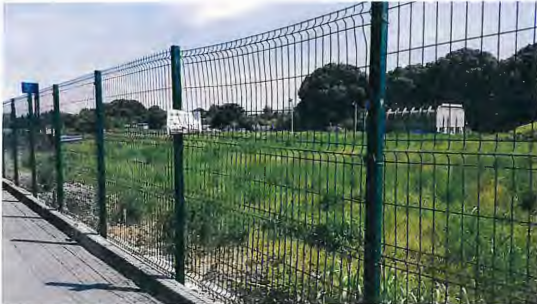
Ripristino recinzione metallica
