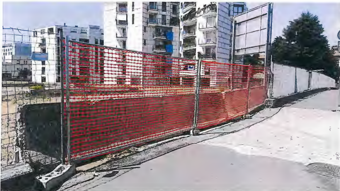
Posizionamento barriere new jersey
