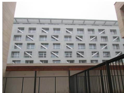
Vista esterna Edificio H (lato sud)
