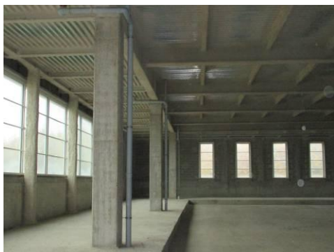
Vista interna Zona Fitness al rustico
