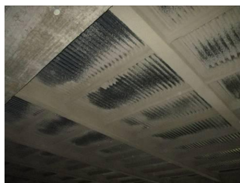
Vista interna Zona Fitness al rustico
