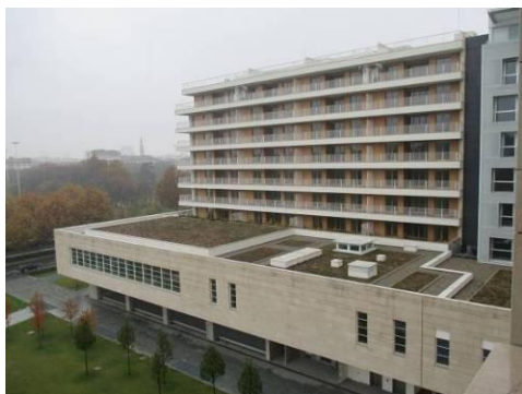
Vista esterna Zona Fitness (Edificio P)
