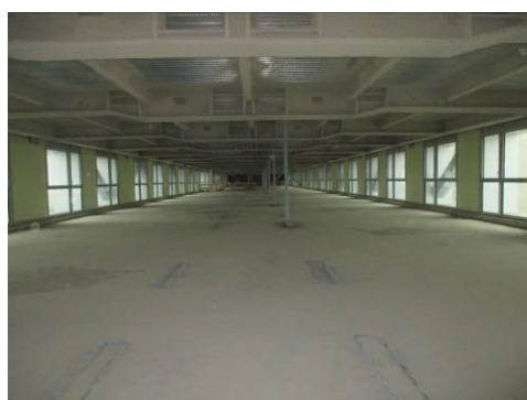
Vista interna Edificio H al rustico
