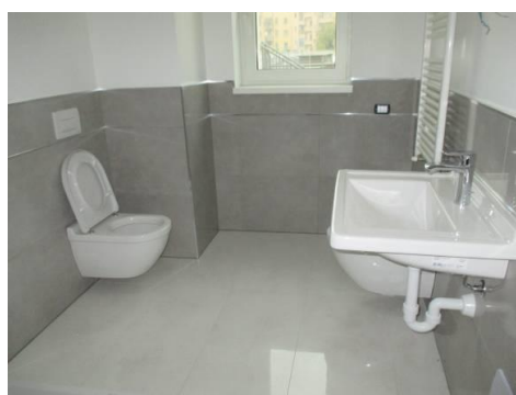
Vista interna appartamento finito Edificio B
