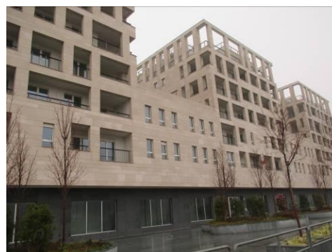
Vista esterna Edifici T (lato sud)
