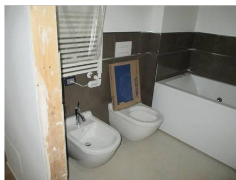
Vista interna appartamento finito Edificio P
