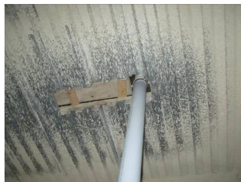
Vista interna Edificio H al rustico
