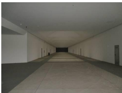
Vista interna galleria commerciale (mall)
