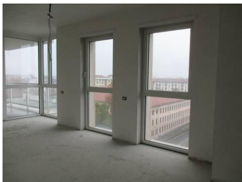
Vista interna appartamento al rustico Edificio C
