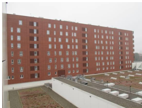
Vista esterna Edificio B (lato nord)
