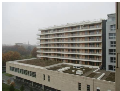
Vista esterna Edificio P (lato sud)
