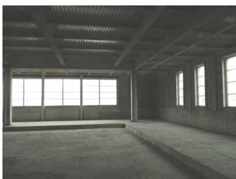
Vista interna Zona Fitness al rustico
