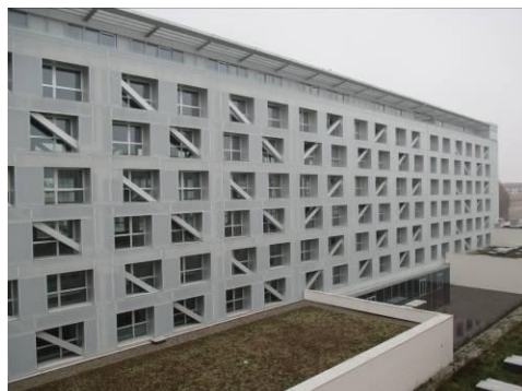
Vista esterna Edificio H (lato sud)
