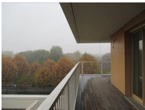
Balcone Edificio P
