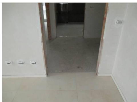
Vista interna appartamento al rustico Edifici T
