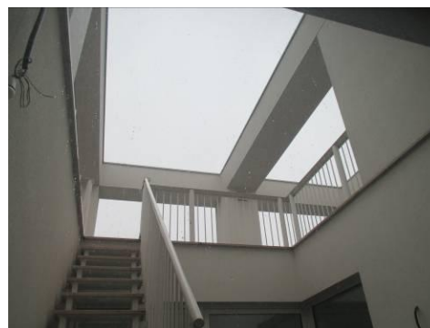
Terrazzo Edificio C
