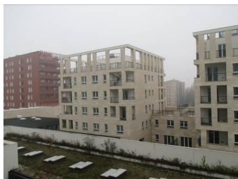
Vista esterna Edifici T (lato nord)
