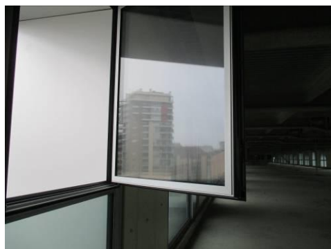
Vista interna Edificio H al rustico
