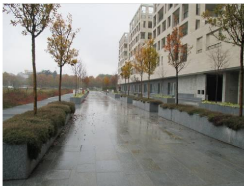
Vista esterna area antistante galleria commerciale
