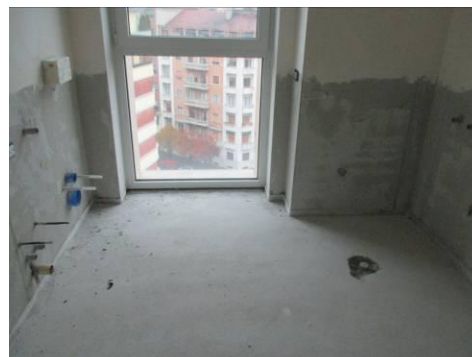
Vista interna appartamento al rustico Edificio C
