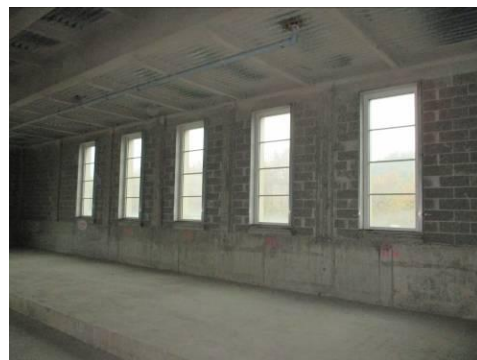
Vista interna Zona Fitness al rustico
