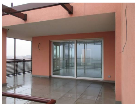
Balcone Edificio B
