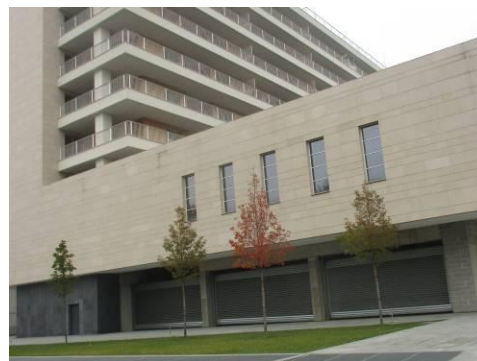
Vista esterna Zona Fitness (Edificio P)
