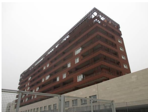
Vista esterna Edificio B (lato sud)
