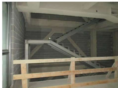
Vista interna Edificio H al rustico
