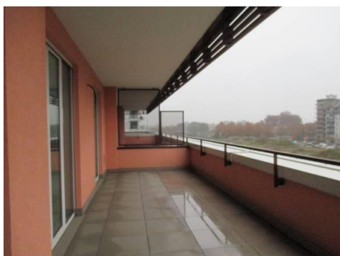
Balcone Edificio B
