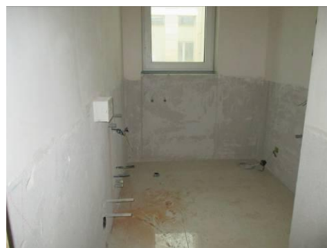
Vista interna appartamento al rustico Edifici T
