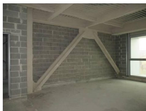
Vista interna Edificio H al rustico
