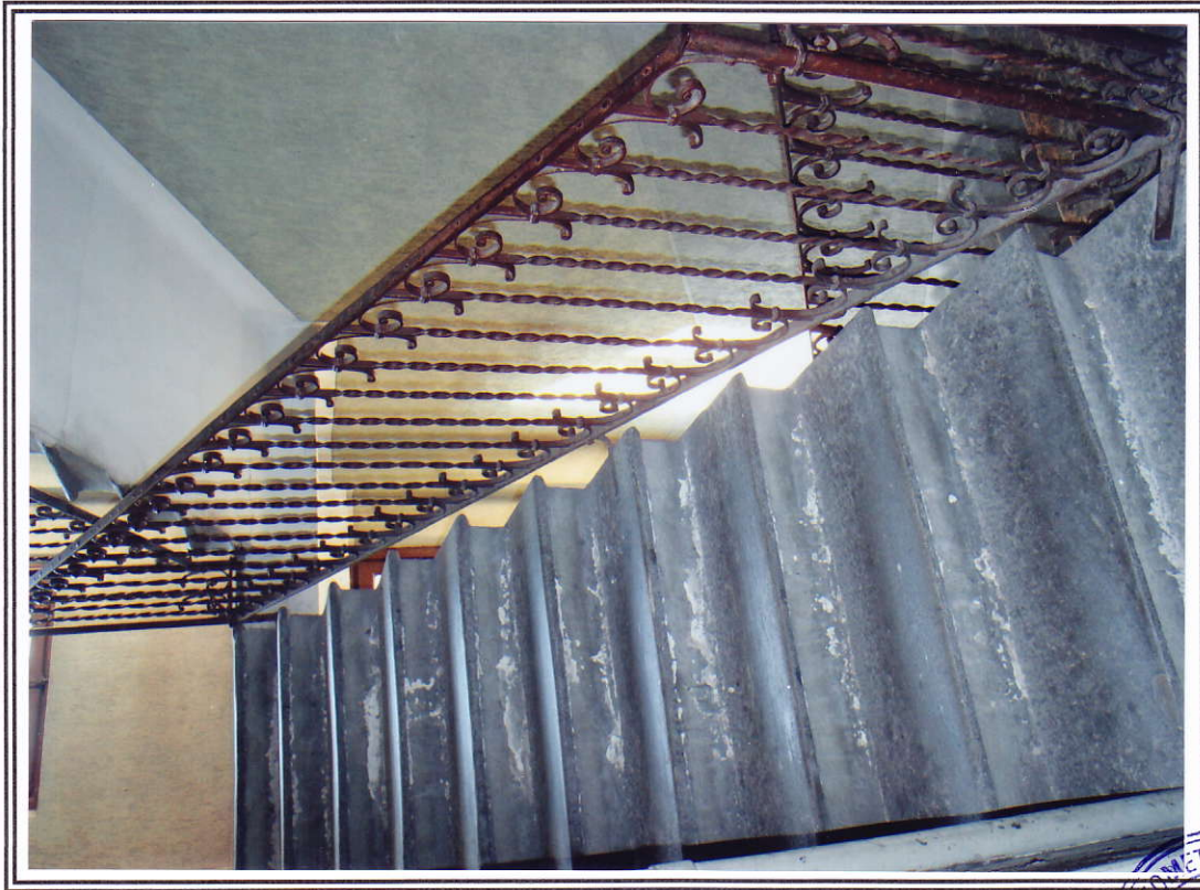
Interno fabbricato – vano scala comune
