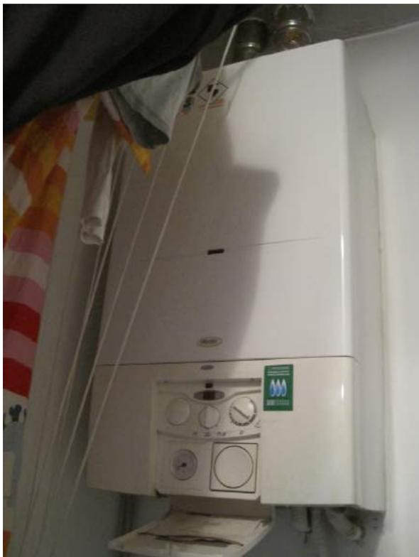
Caldaia autonoma per riscaldamento e produzione ACS
