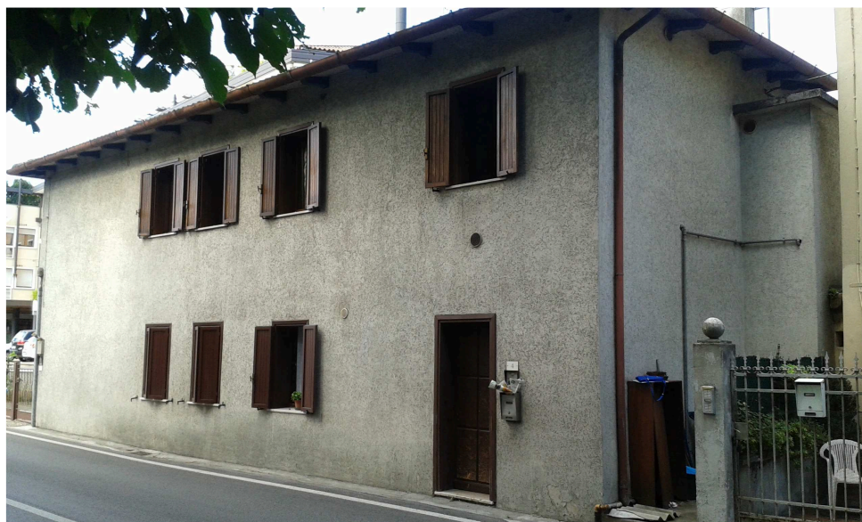
Foto 1 - lato ovest con ingresso da via Fonderia
