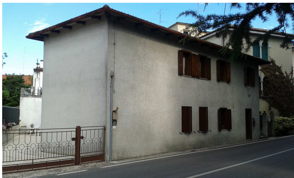
Foto 2 – lato nord-ovest da via Fonderia
