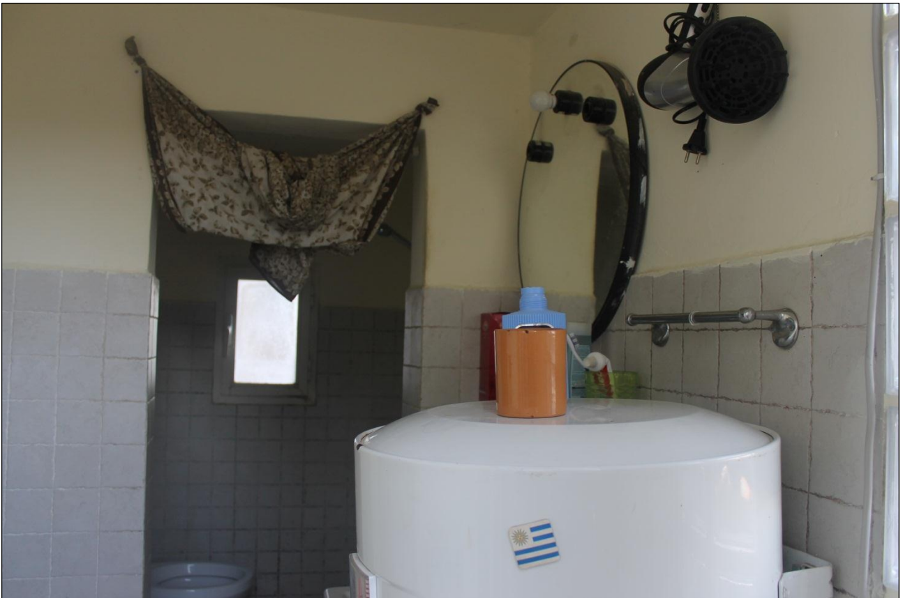
Servizio igienico al primo piano
