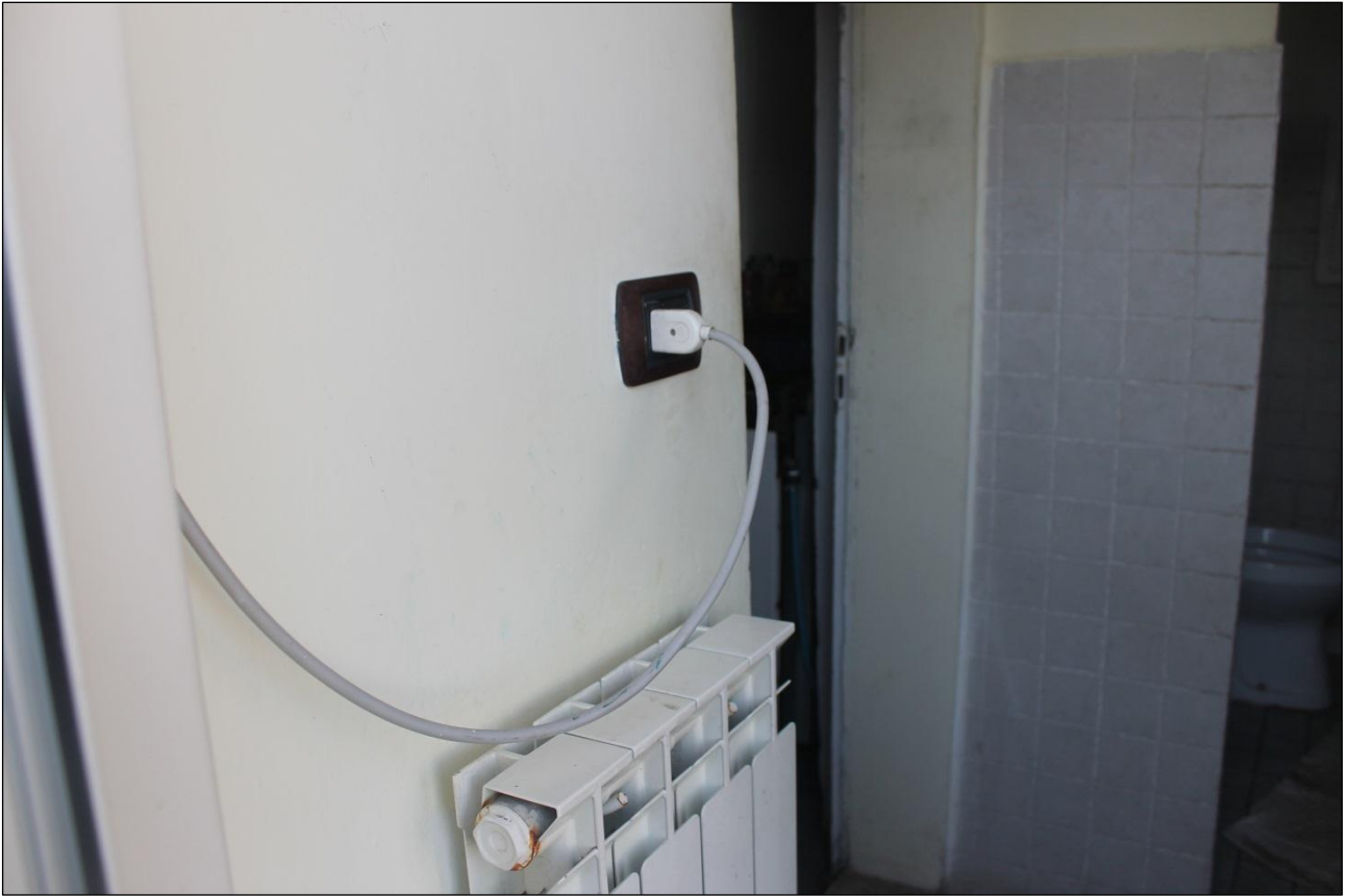
Disimpegno al primo piano
