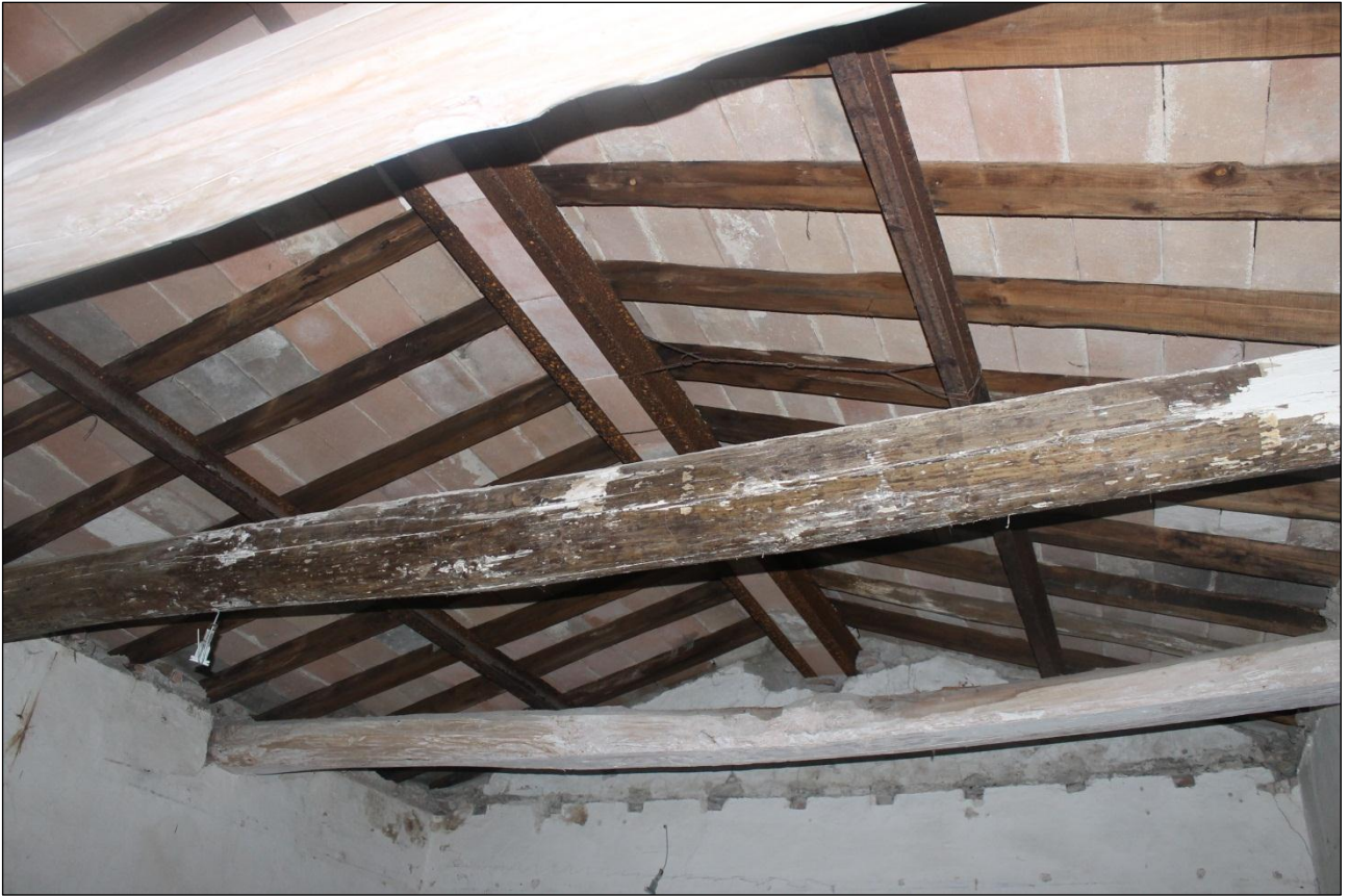
Solaio di copertura
