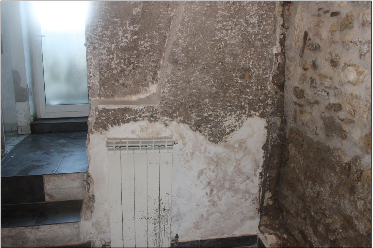
Cucina al piano terra
