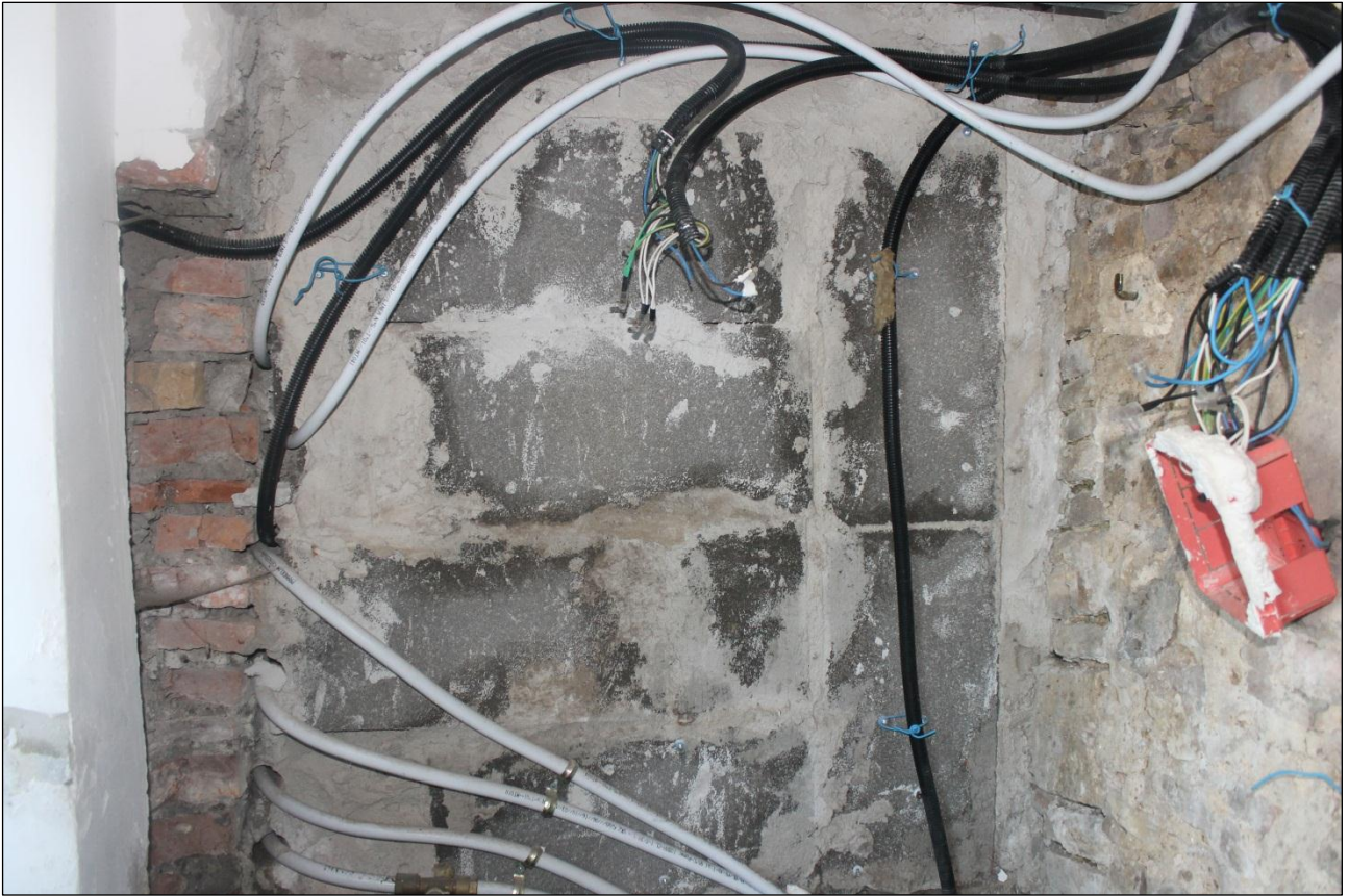
Disimpegno al piano terra
