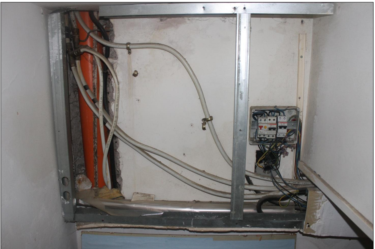
Disimpegno al piano terra
