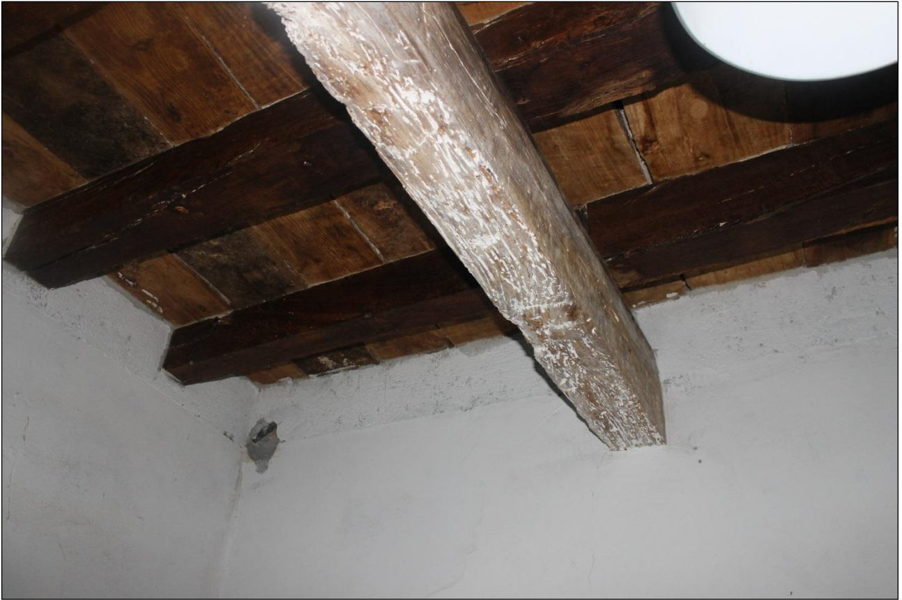
Solaio di interpiano ( fra primo e secondo piano )
