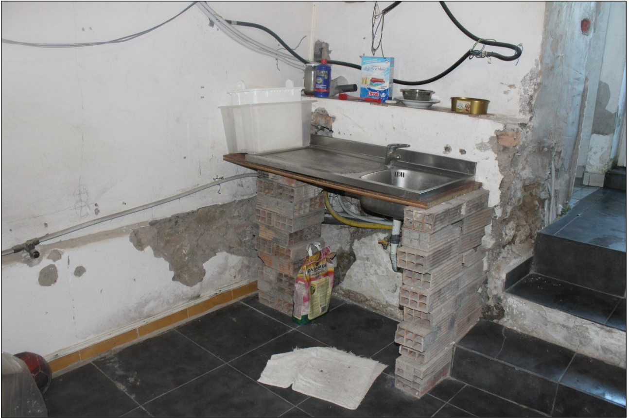
Cucina al piano terra
