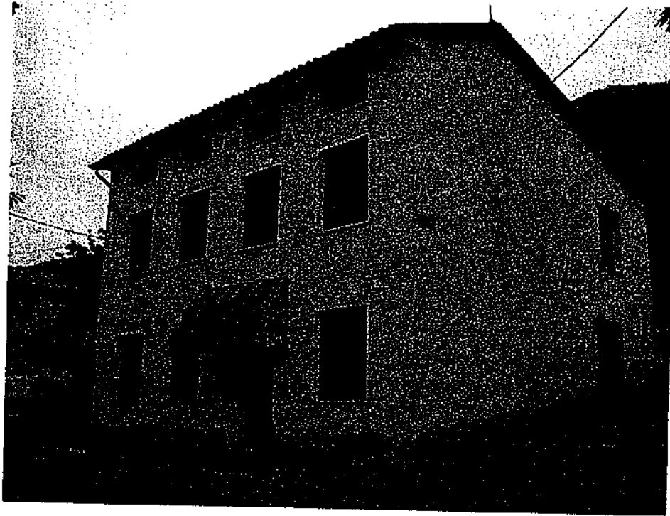
Posizione 1 - fabbricato via Burat 13.
