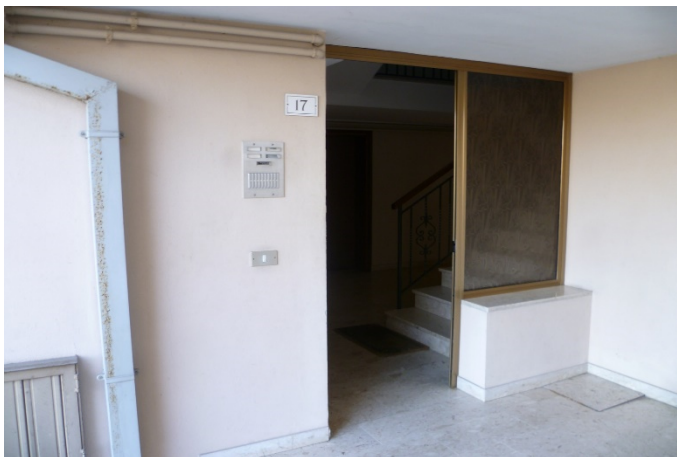
foto n. 7 – ingresso Scala A
