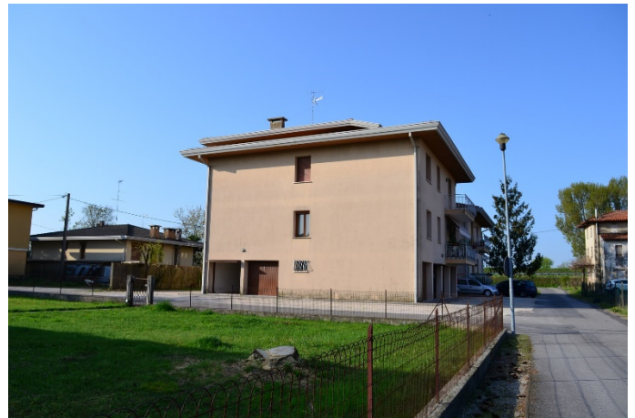
foto n. 2 – condominio - prospetto est
