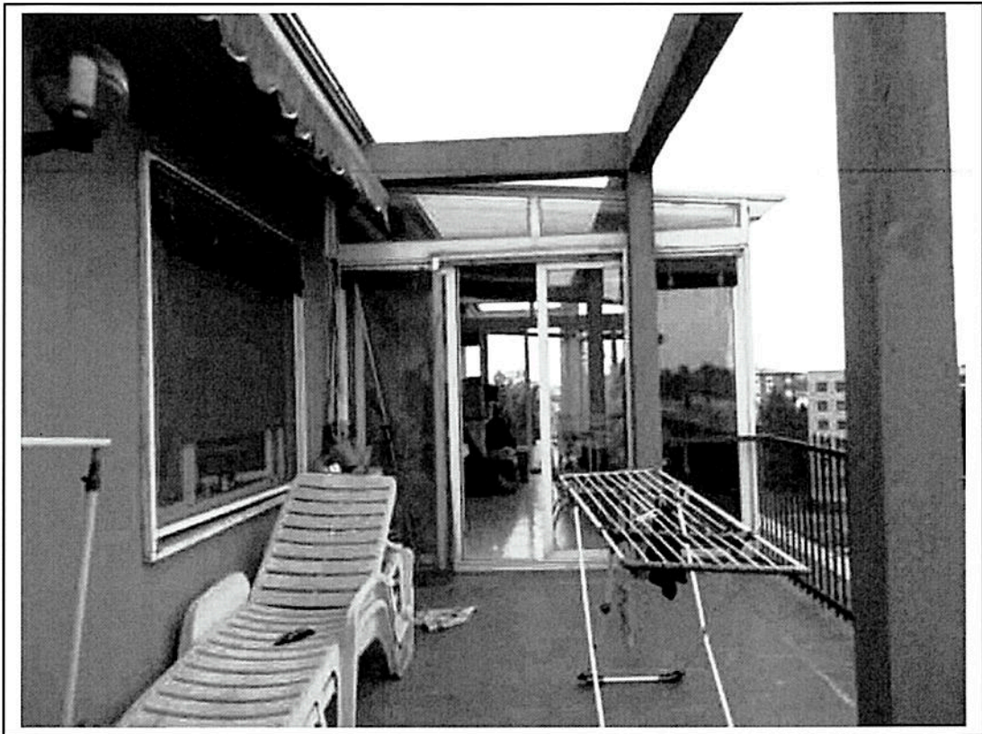
Fotografia n°17 – Vista della veranda dal terrazzo.
