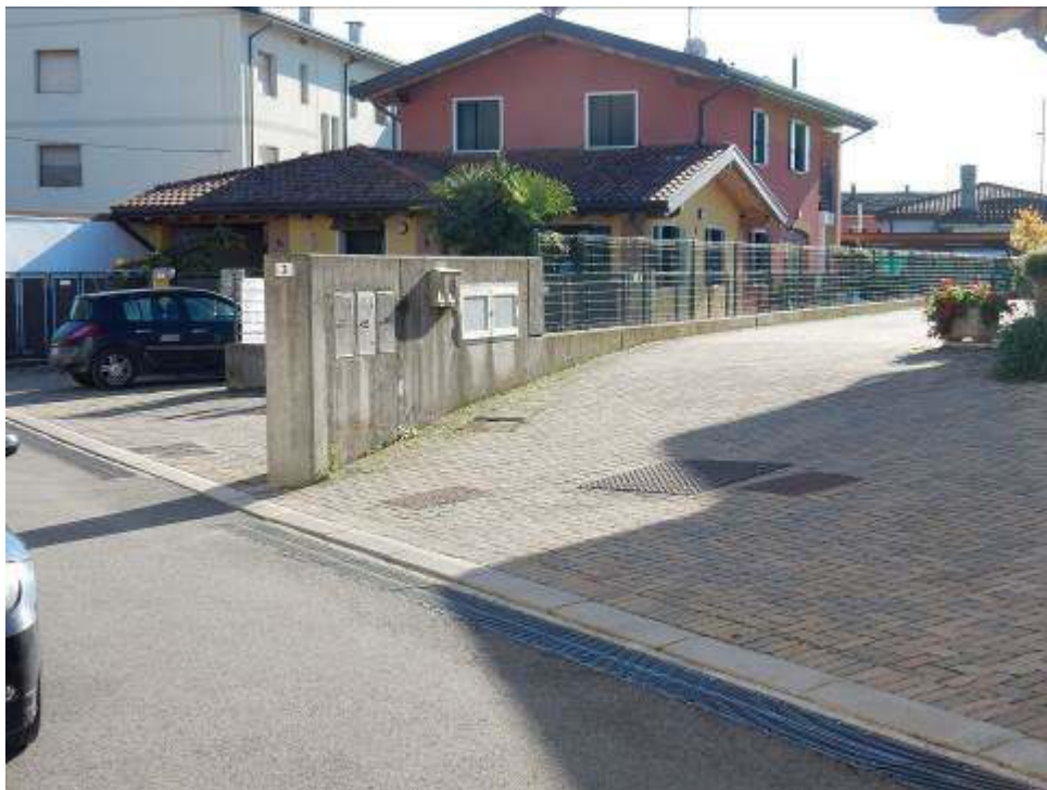
Foto 25-26: Piazzale esterno ingresso abitazione.
