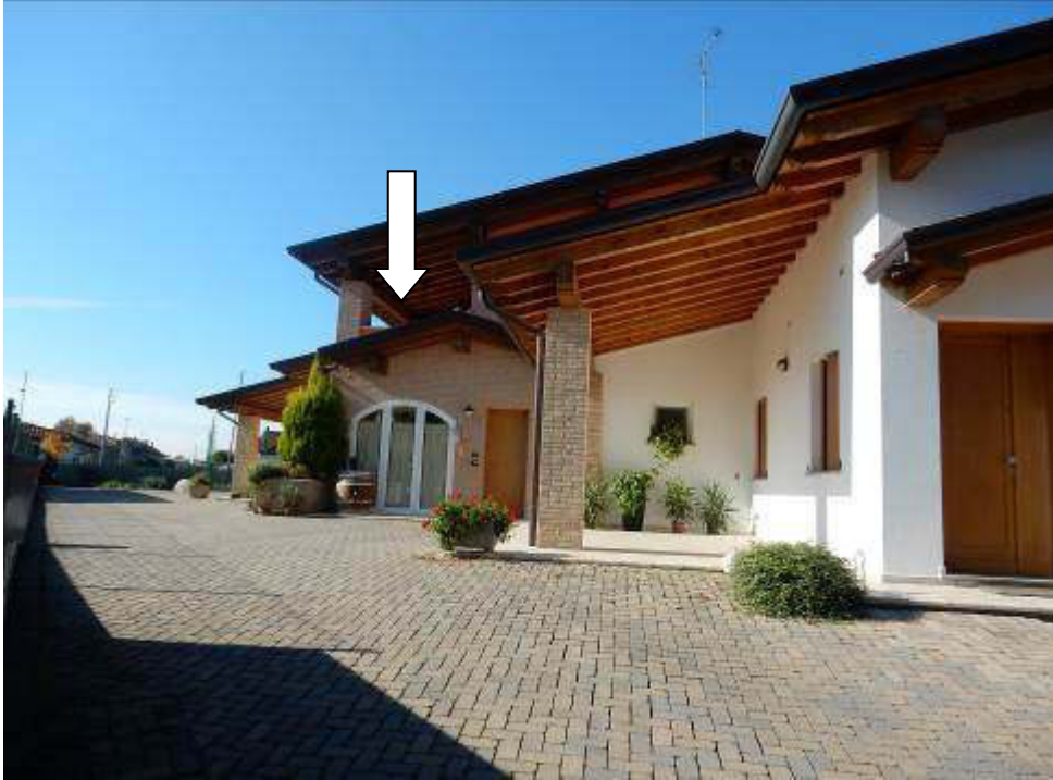
Foto 1-2: Fabbricato di abitazione lato Sud e lato Ovest.
