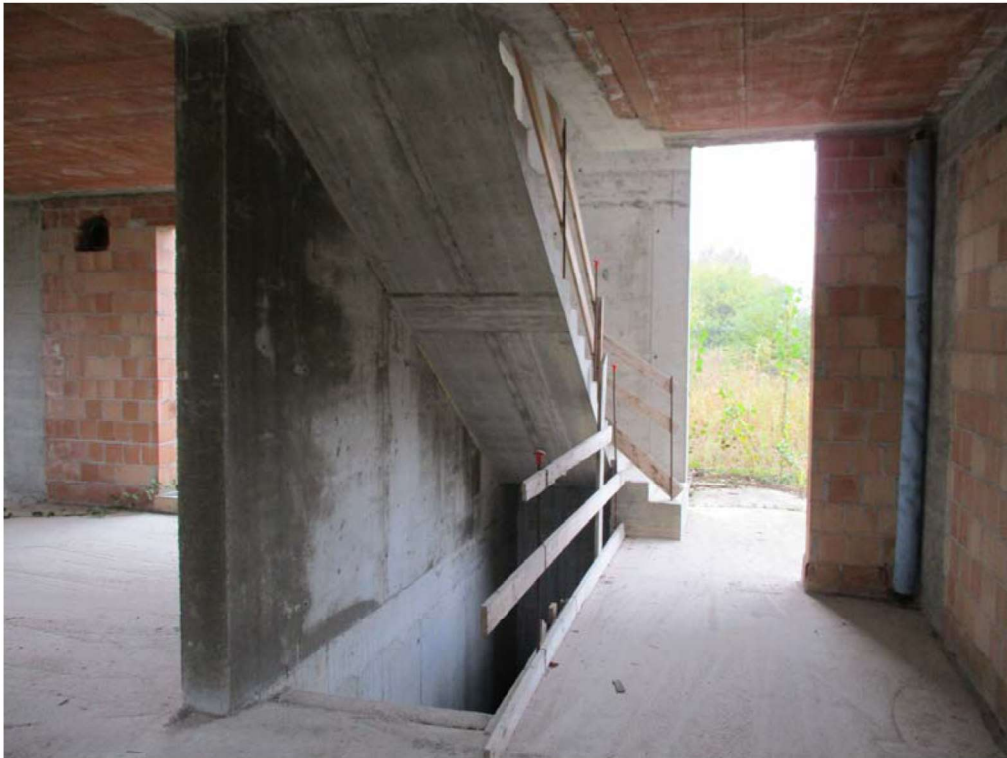
FOTO n°7. - visione interna fabbricato - Piano Terra - LOTTO A1
