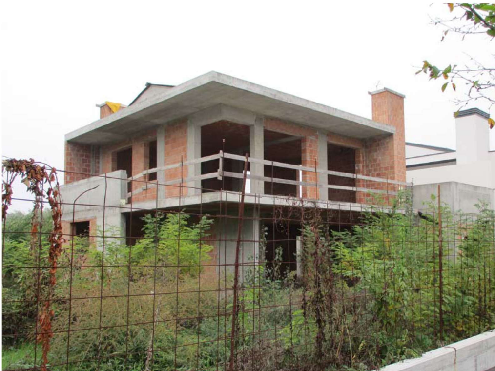
FOTO n°2. - visione esterna fabbricato – LOTTO A1
