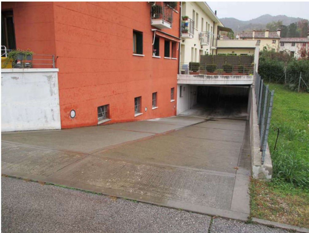
FOTO n°10. - visione rampa accesso al piano interrato - LOTTO B1
