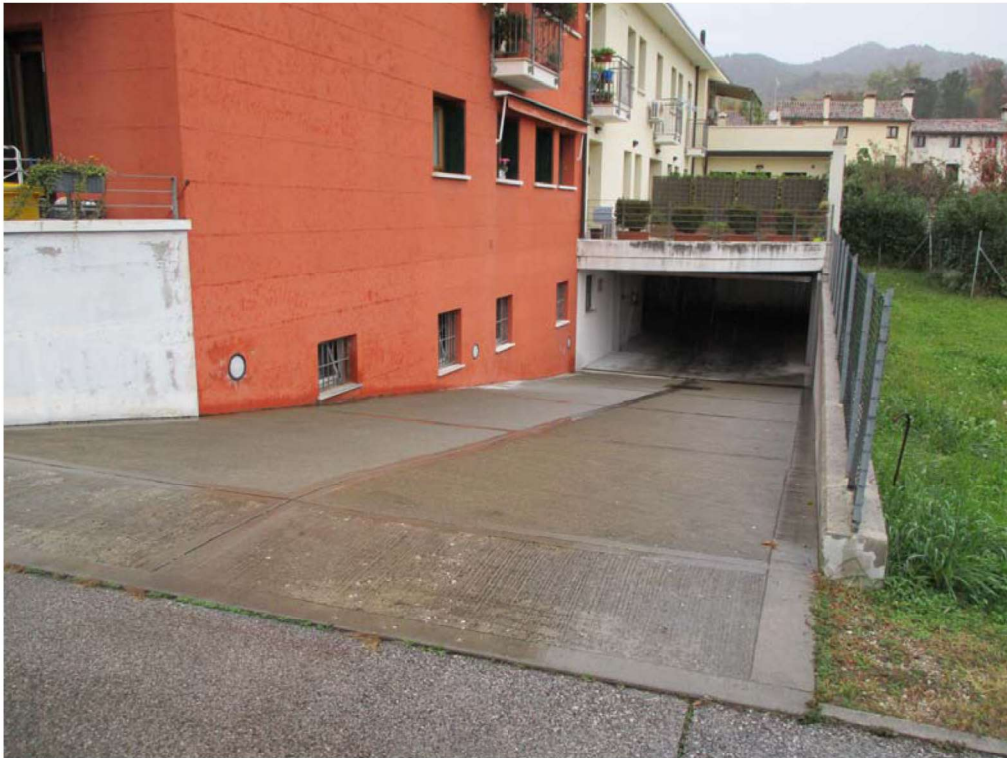
FOTO n°15. - visione rampa accesso al piano interrato – LOTTO B3
