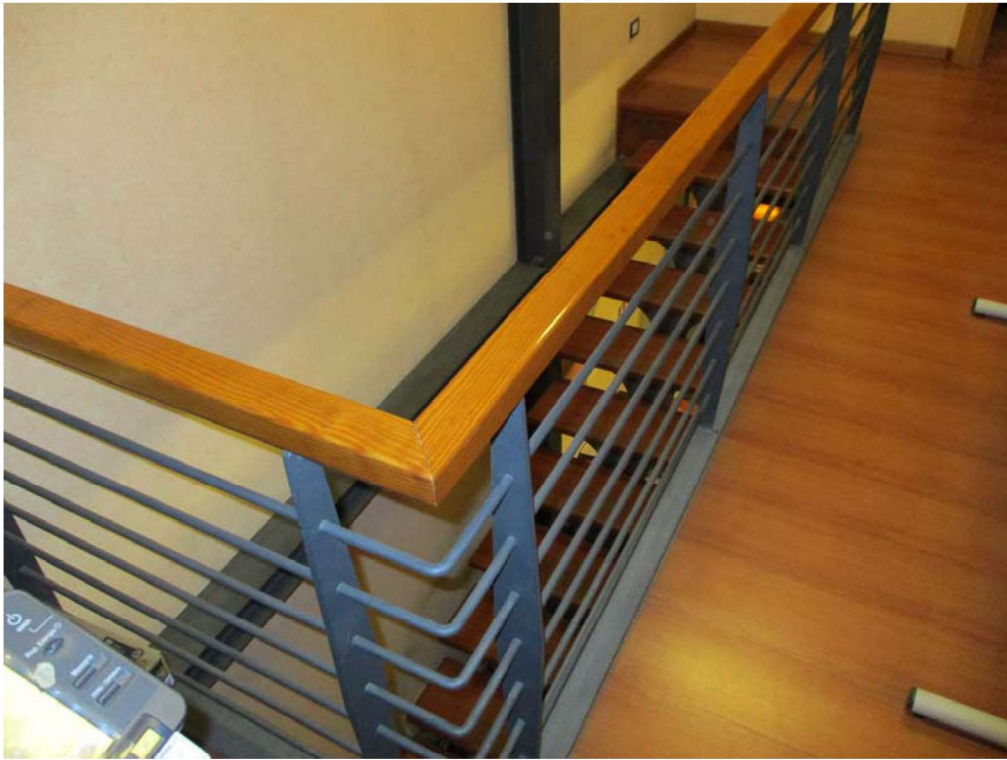
FOTO n°23. - visione interna LOTTO B4 - scala accesso uffici piano primo
