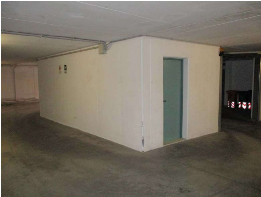
FOTO n°16. - visione magazzino sub. 14 – LOTTO B3
