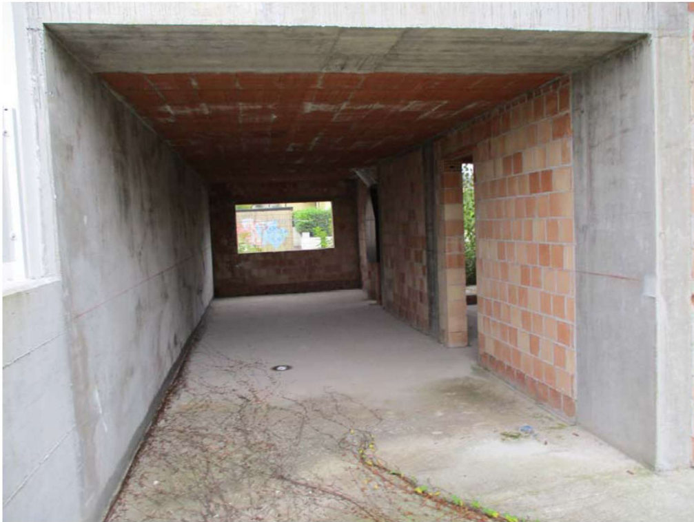
FOTO n°5. - visione interna fabbricato - Piano Terra - LOTTO A1
