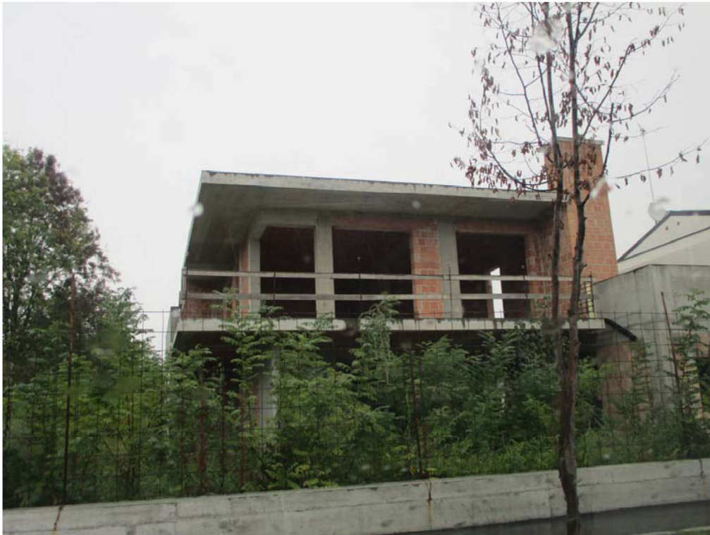
FOTO n°1. - visione esterna fabbricato – LOTTO A1
