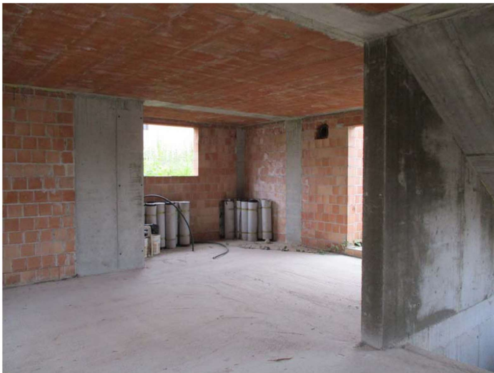
FOTO n°6. - visione interna fabbricato - Piano Terra - LOTTO A1
