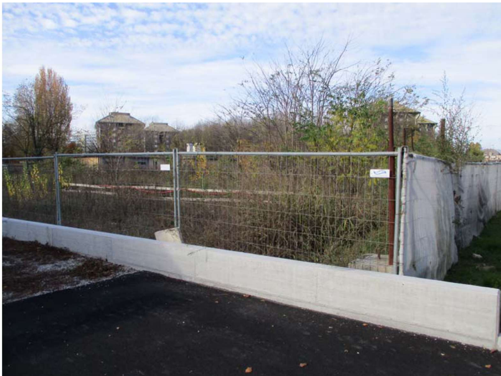
FOTO n°13. - visione esterna fabbricato - LOTTO A2
