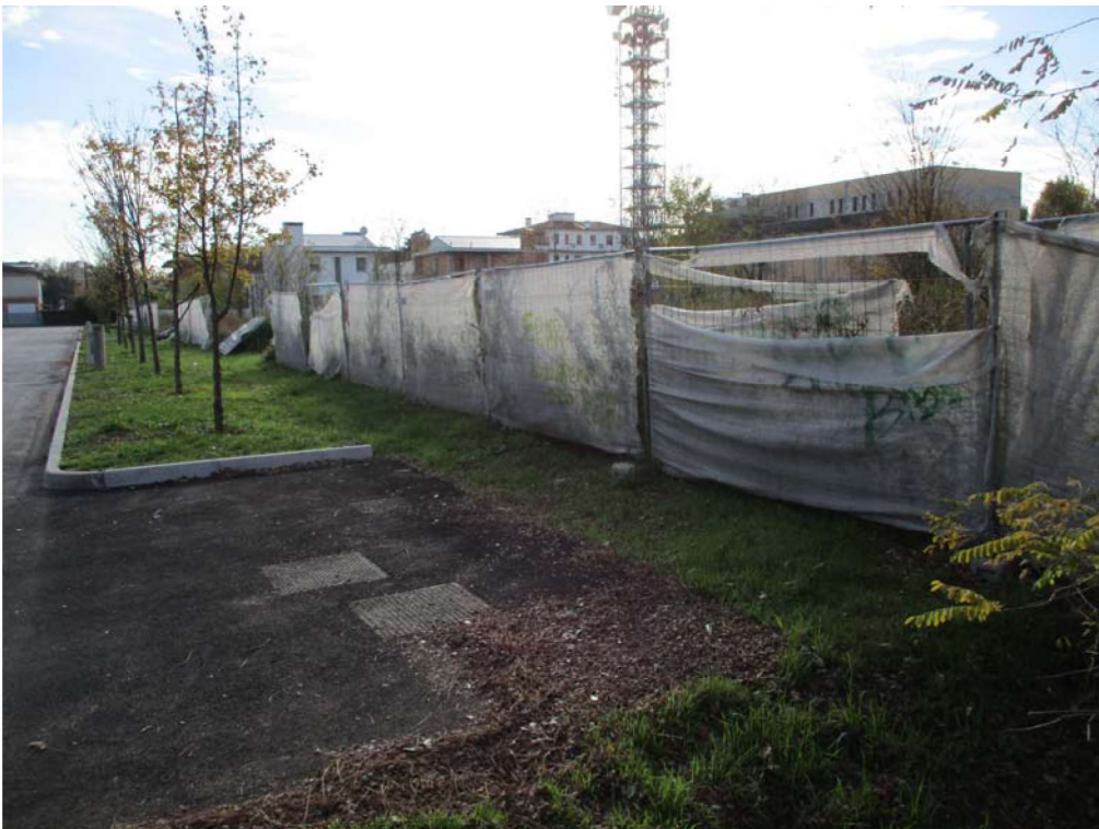
FOTO n°15. - visione terreni - LOTTO A3
