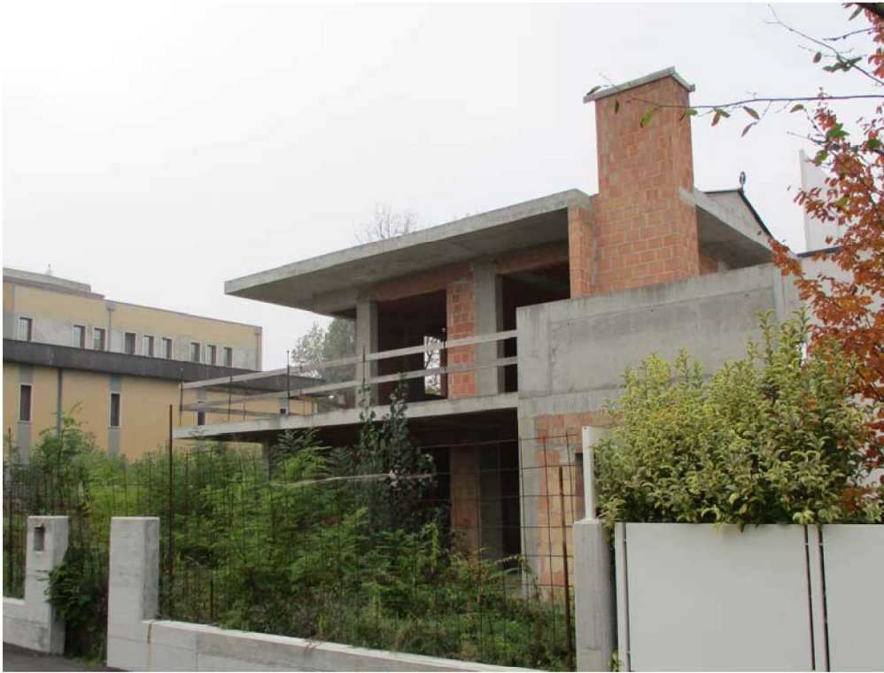
FOTO n°3. - visione esterna fabbricato - LOTTO A1
