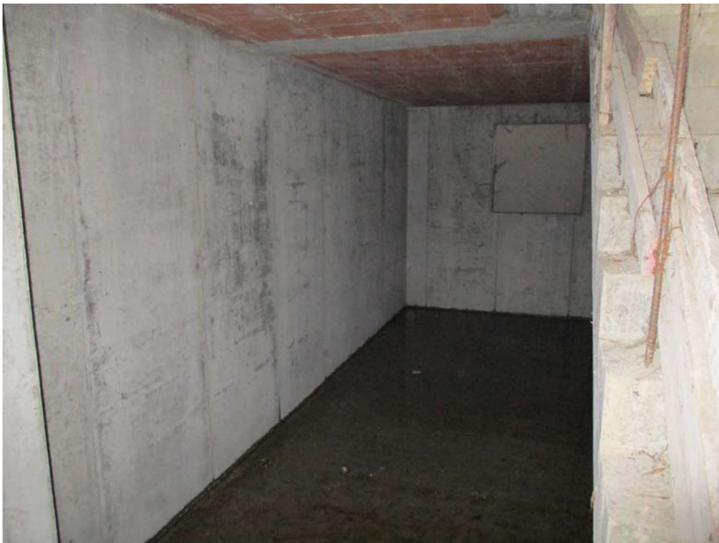
FOTO n°10. - visione interna fabbricato - Piano Interrato - LOTTO A1
