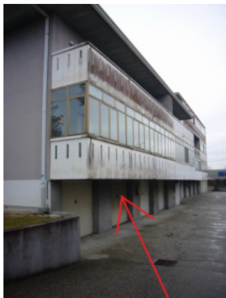
particolare ingresso garage lato Est
