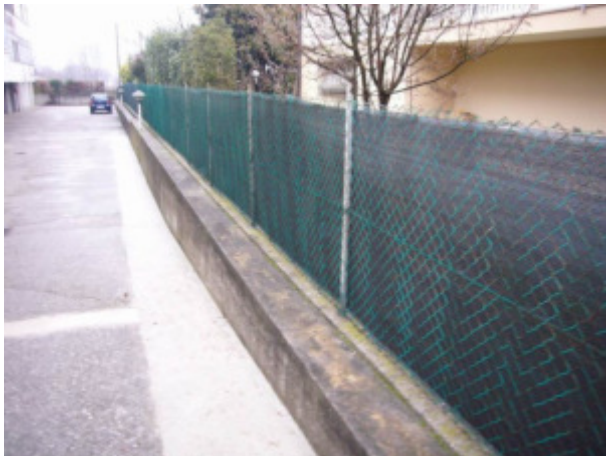
Particolare spazio di manovra di accesso ai garage
