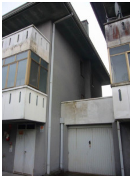
particolare prospetto lato Nord/Est
