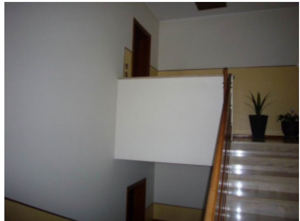
particolare vano scala comune
