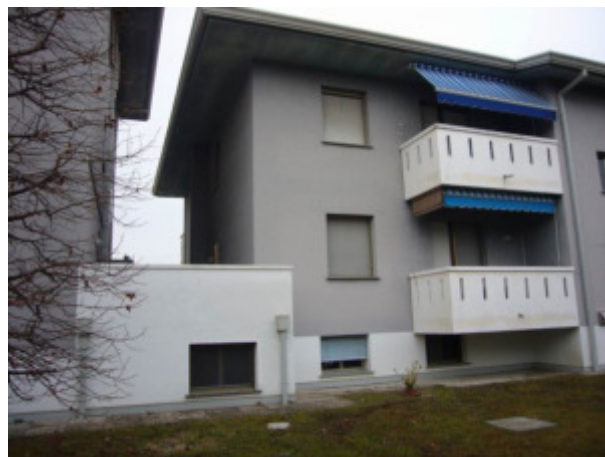
particolare prospetto lato Nord/Ovest
