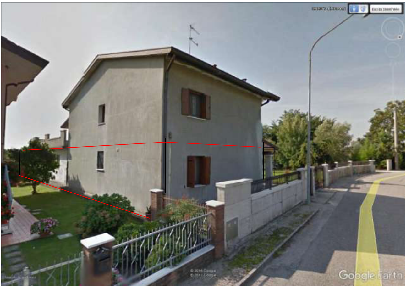
Foto 2 Retro con evidenziata porzione oggetto di esecuzione
