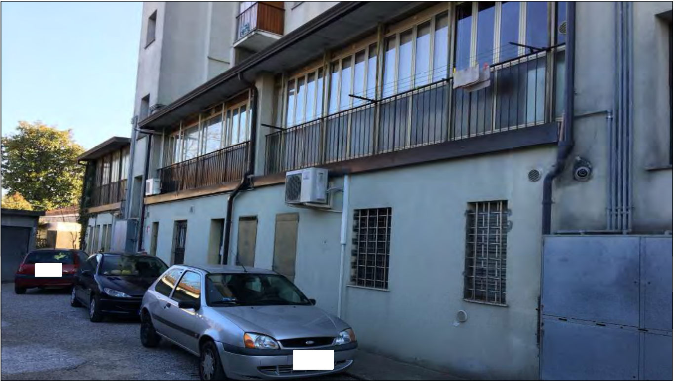
Foto Esterno cantine
