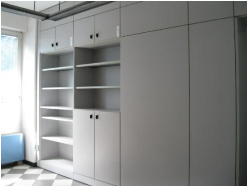
Foto 12 Parete attrezzata che funge da divisorio
