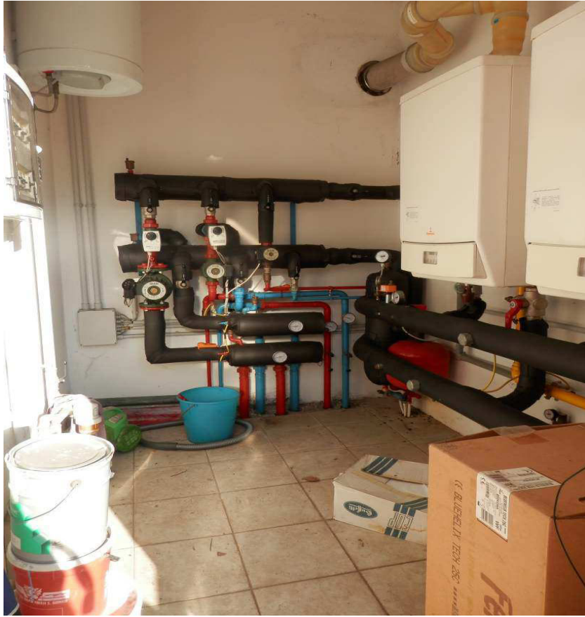
VANO CALDAIA COMUNE
