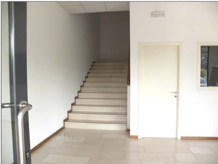
Fontanafredda (PN) - immobili non operativi: unità al grezzo (ingresso principale al compendio - da Nord)
