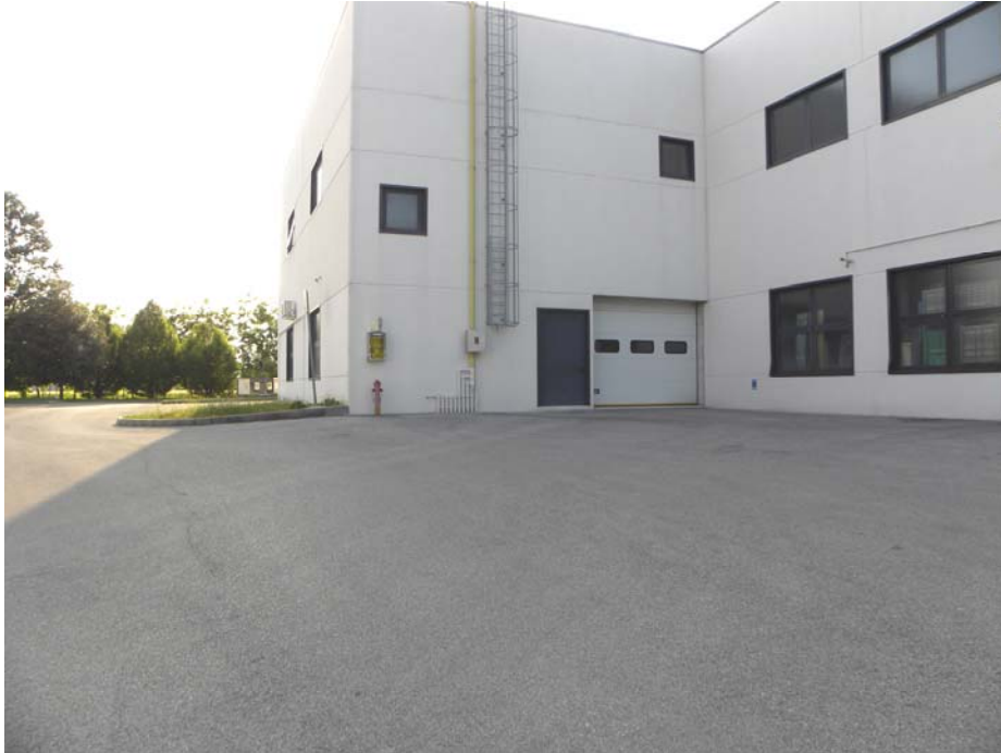
Fontanafredda (PN) - immobili non operativi: unità al grezzo (ingresso posteriore - da Est)
