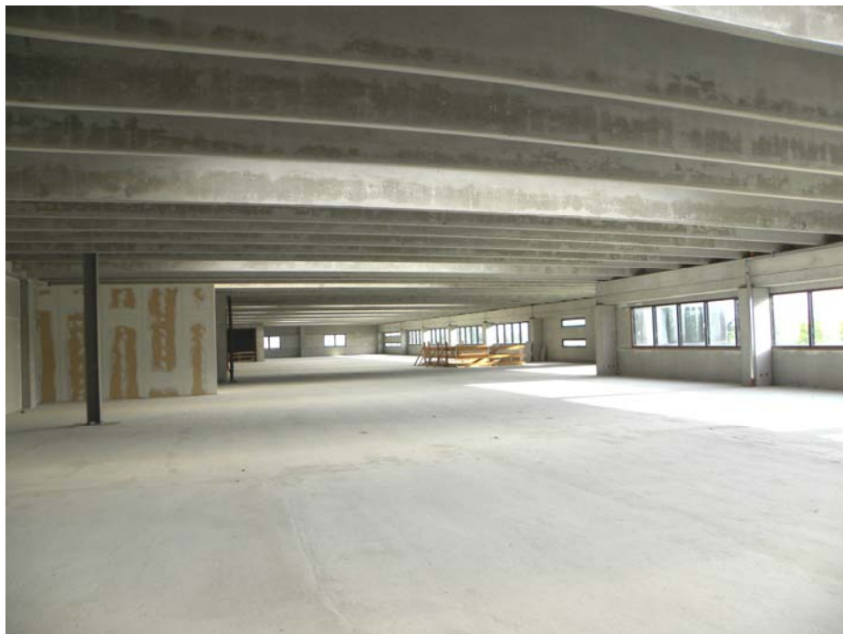
Fontanafredda (PN) - immobili non operativi: unità al grezzo (vista d'insieme dei locali)
