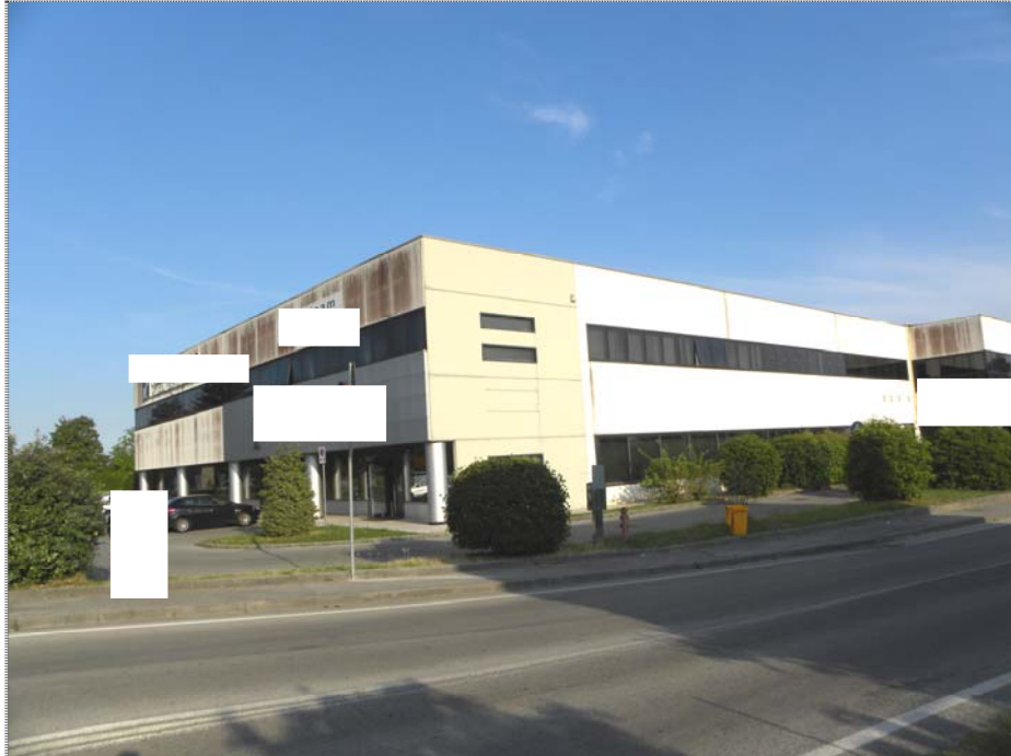
Fontanafredda (PN) - immobili non operativi: unità al grezzo (vista d'insieme del compendio)
