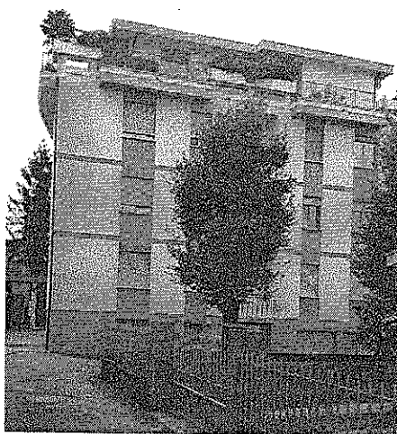
Facciata lato Nord
