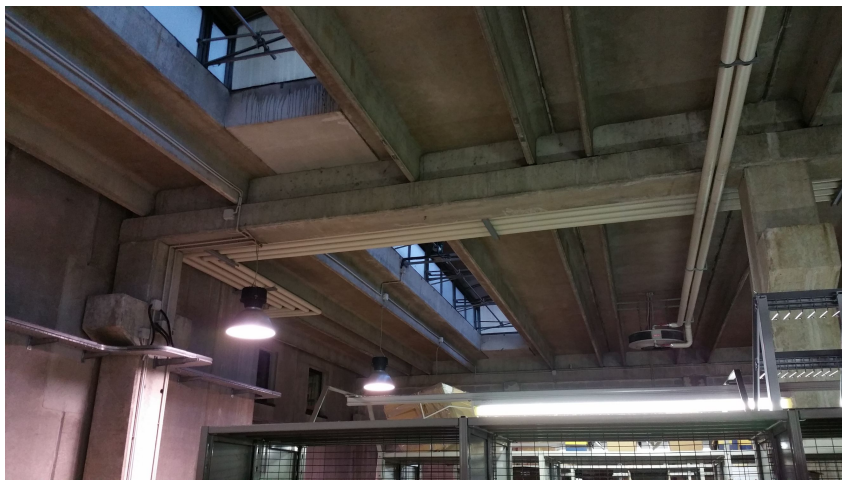
Struttura del Magazzino - Lucernai
