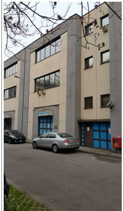
Ingresso zona uffici
