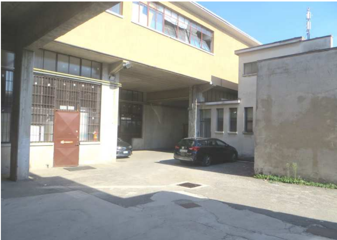
Vista del fabbricato sul retro verso area cortilizia
