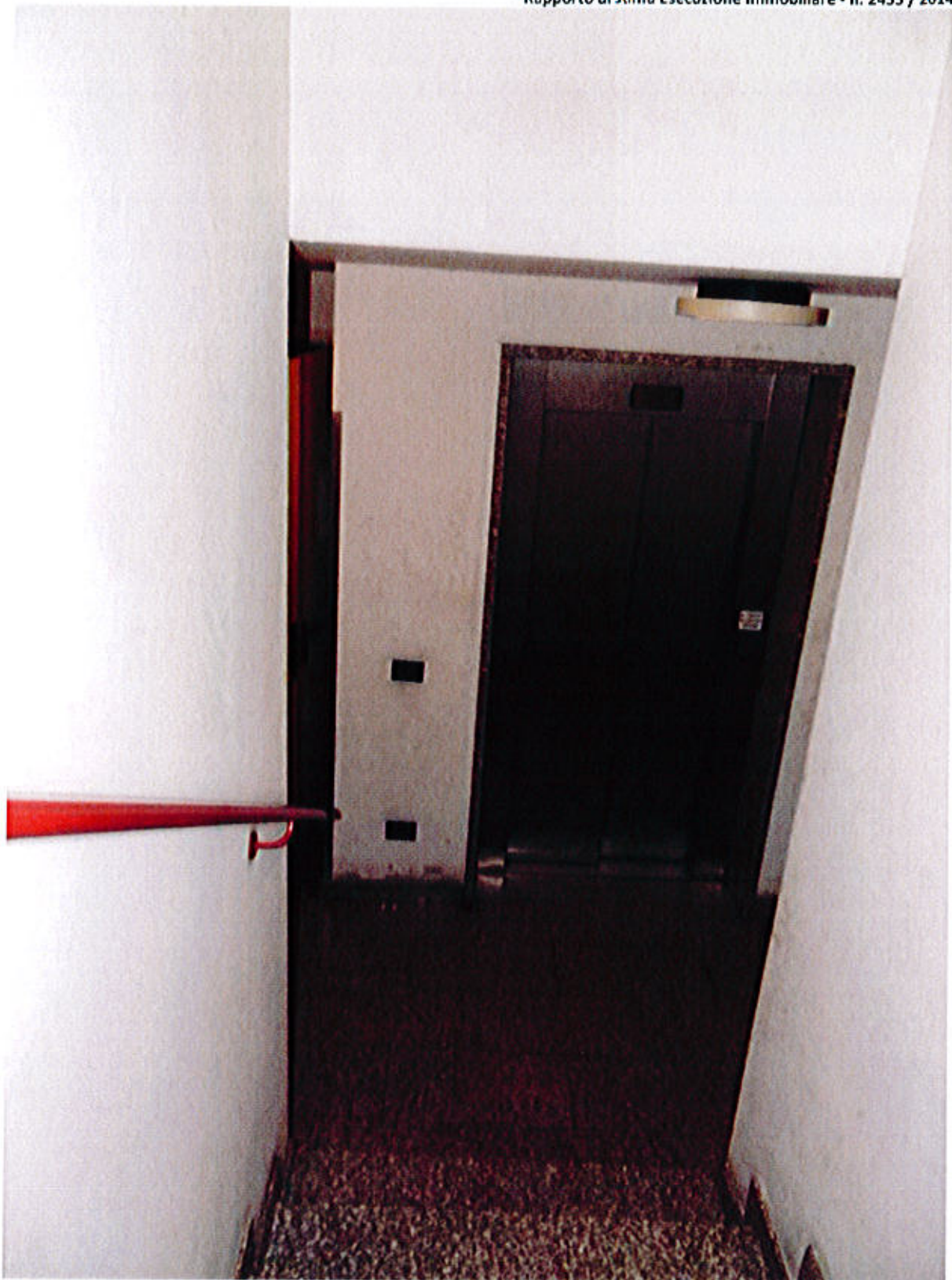
Foto 16 area accesso box dalle scale e con ascensore al piano S1
