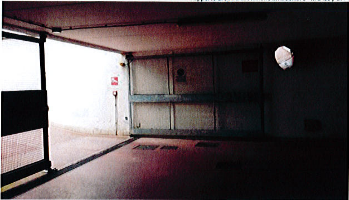
Foto 3 ingresso interno con cancello automatico
