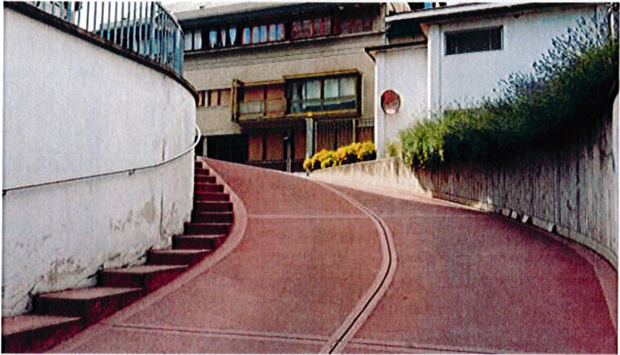
Foto 1 Ingresso rampa di accesso al piano S1 – Primo Cannello
