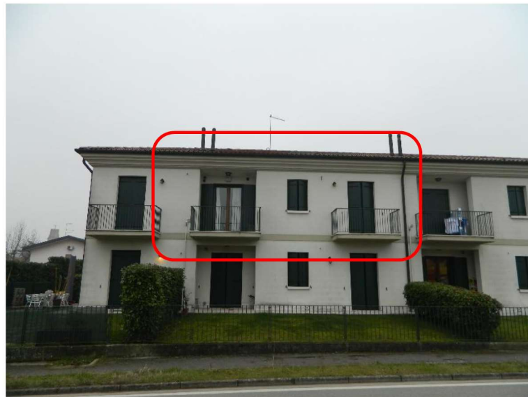
ESTERNO FRONTE NORD
