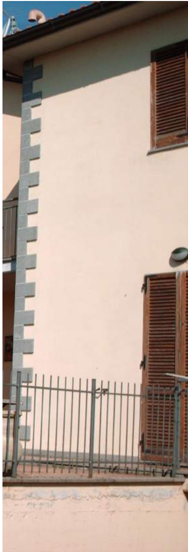
Foto 8: PARZIALE PROSPETTO SUD-EST DELL'ABITAZIONE; PIANO TERRA E PRIMO;
