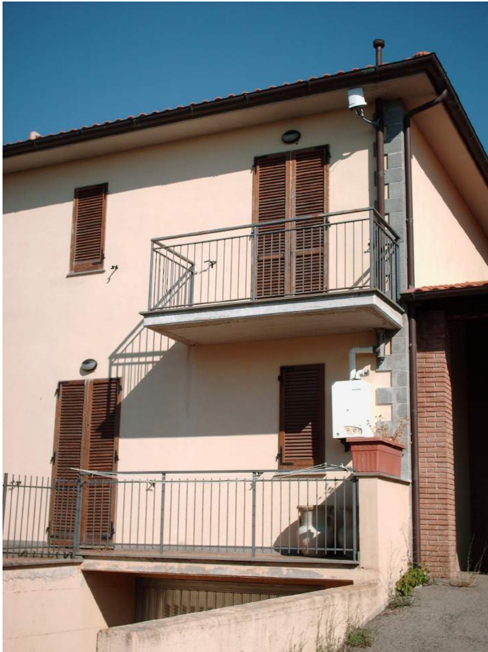
Foto 7: PARZIALE PROSPETTO SUD-EST DELL'ABITAZIONE; PIANO TERRA E PRIMO
