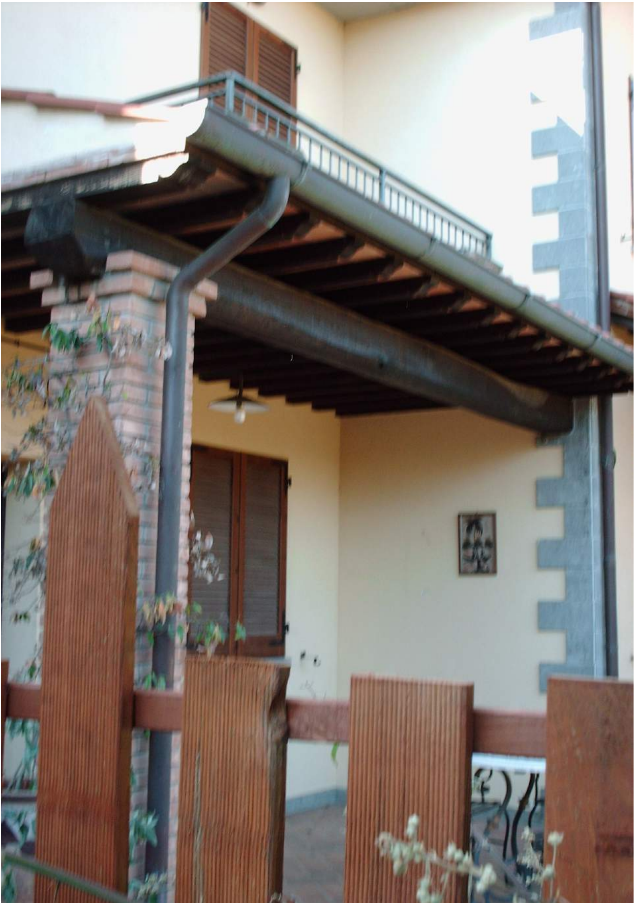
Foto 6: PROSPETTO NORD-NORD OVEST DELL'ABITAZIONE; IN PRIMO PIANO IL CANCELLO DI ENTRATA
