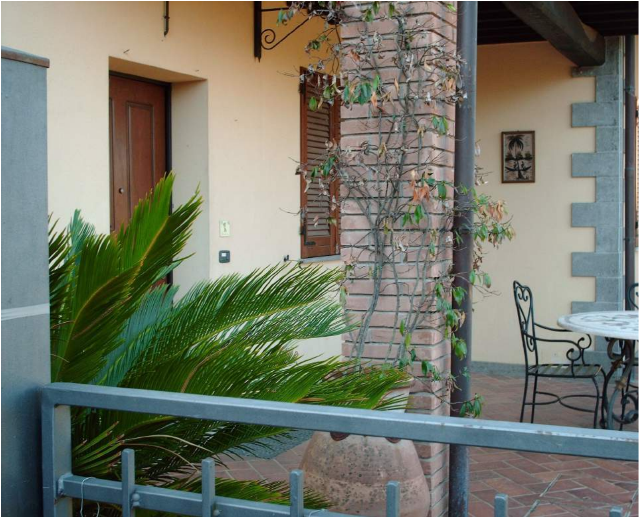
Foto 5: PROSPETTO NORD-NORD OVEST DELL'ABITAZIONE; PIANO TERRA
