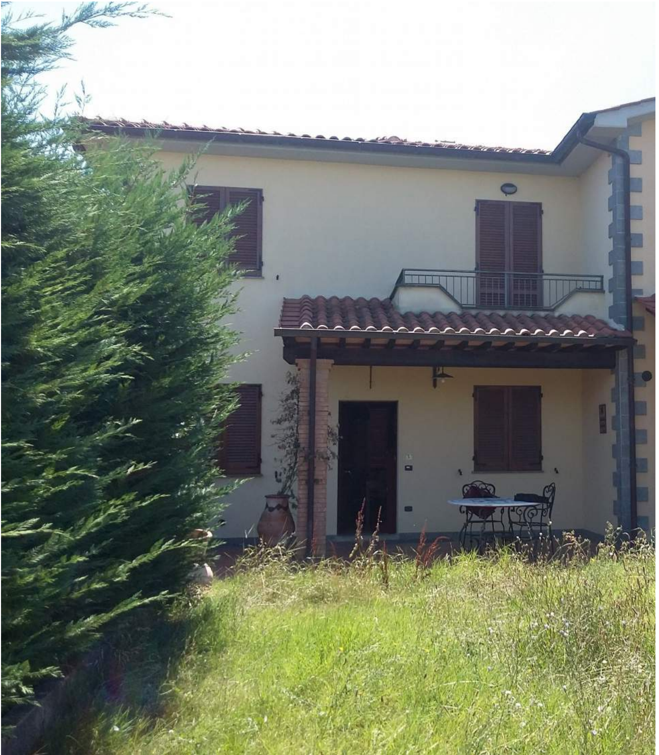
Foto 4: PROSPETTO NORD-OVEST DELL'ABITAZIONE
