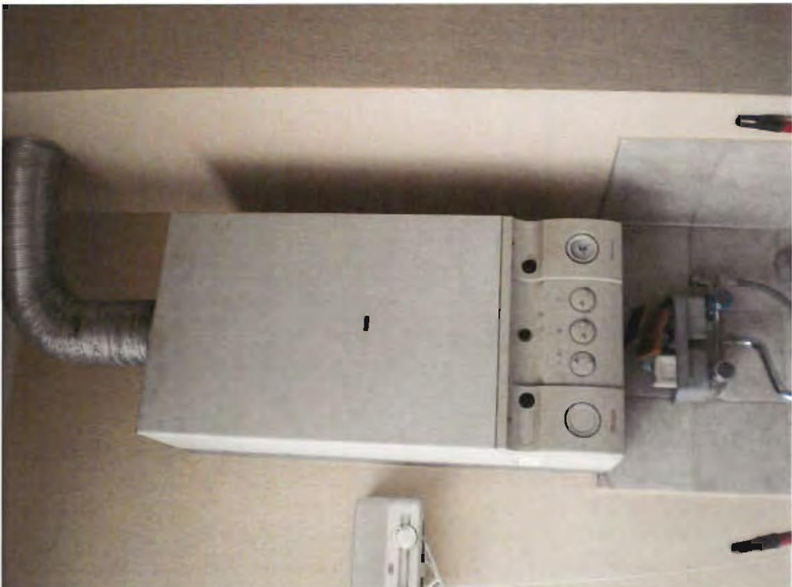
Foto n. 30 – particolare caldaia autonoma a gas metano
