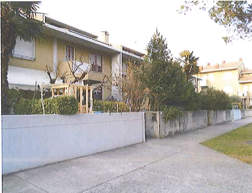
Fronte S-E: Ingresso
