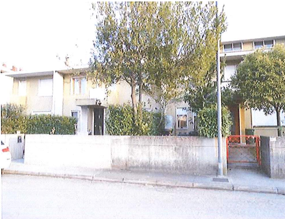
Fronte Nord Ovest: Retro
