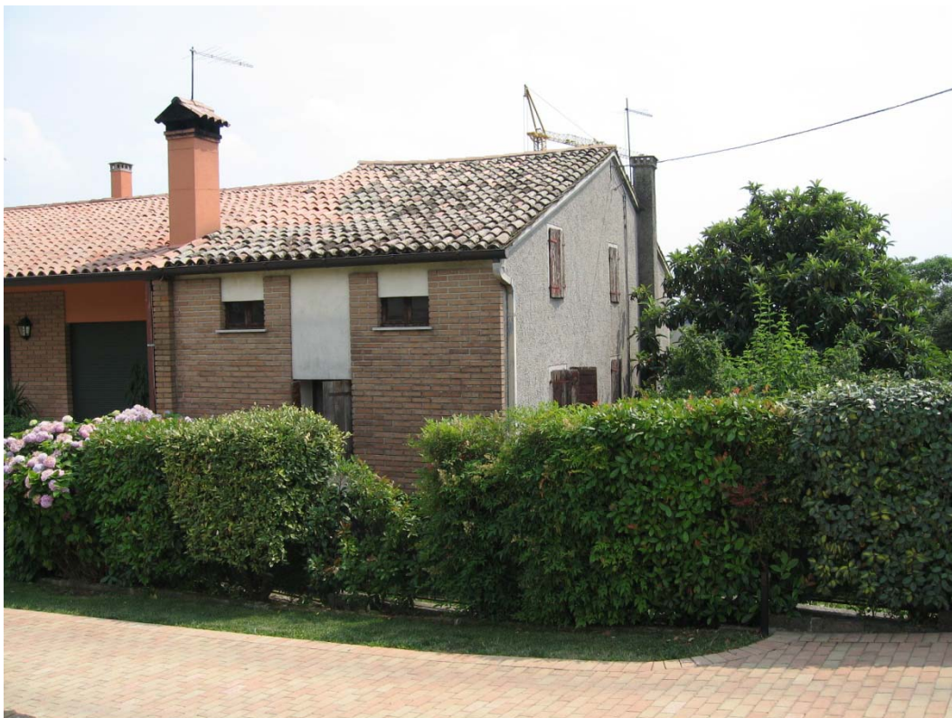
Foto 1: vista nord-ovest fabbricato esistente da demolire
