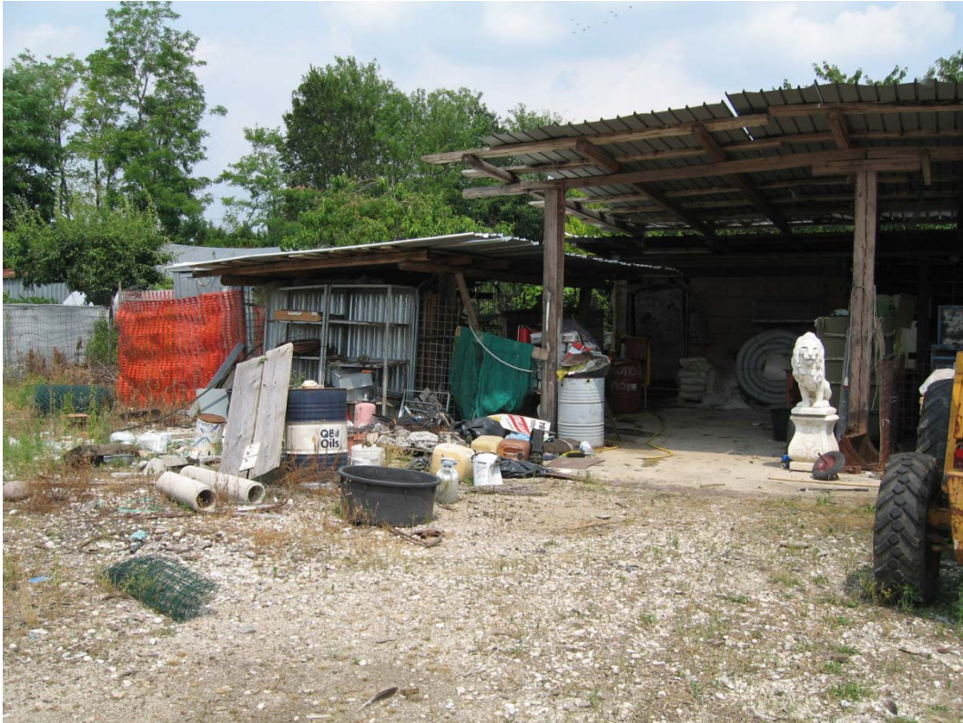
Foto 7: vista ovest fabbricato accessorio esistente abusivo da demolire
