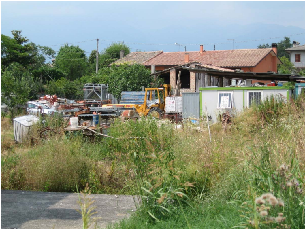
Foto 8: vista generale fabbricati/porzioni da demolire
