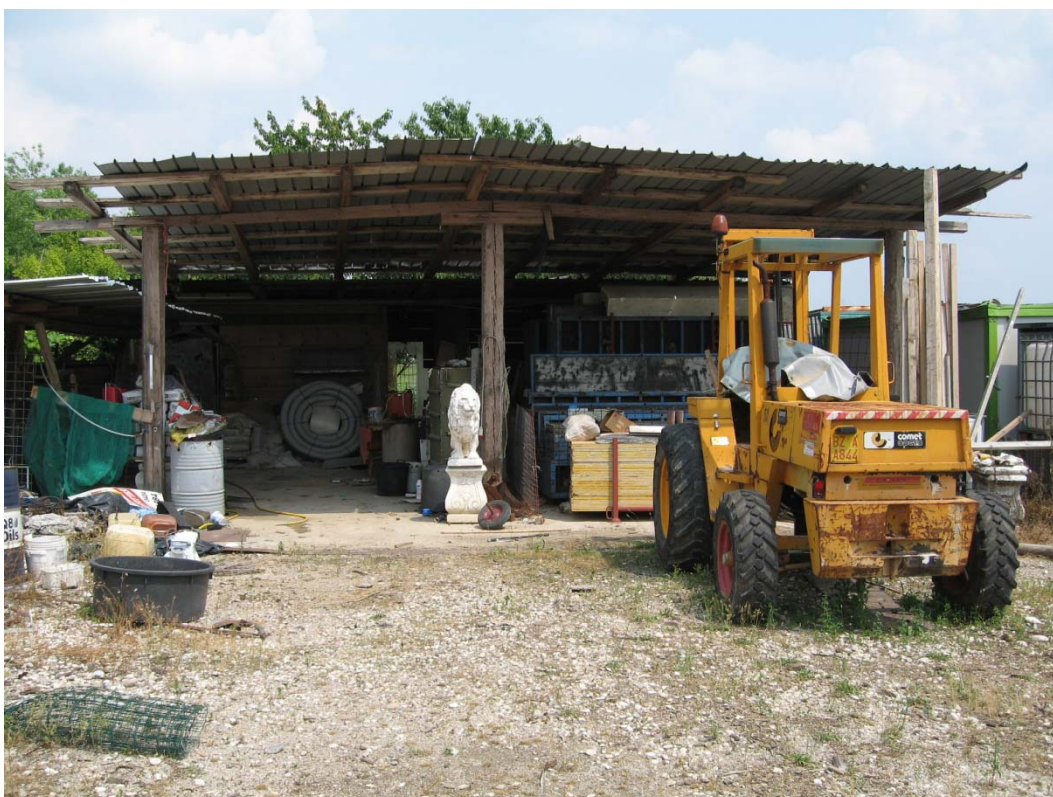
Foto 6: vista ovest fabbricato accessorio esistente abusivo da demolire
