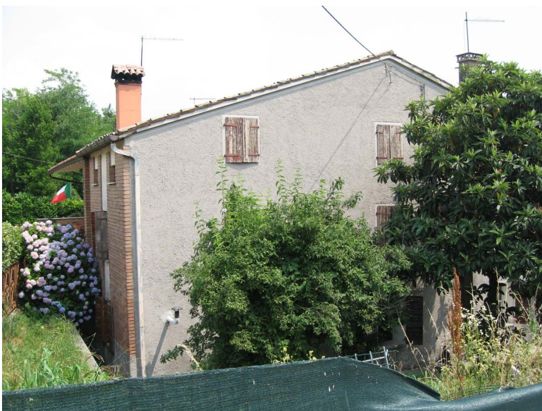
Foto 2: vista ovest fabbricato esistente da demolire
