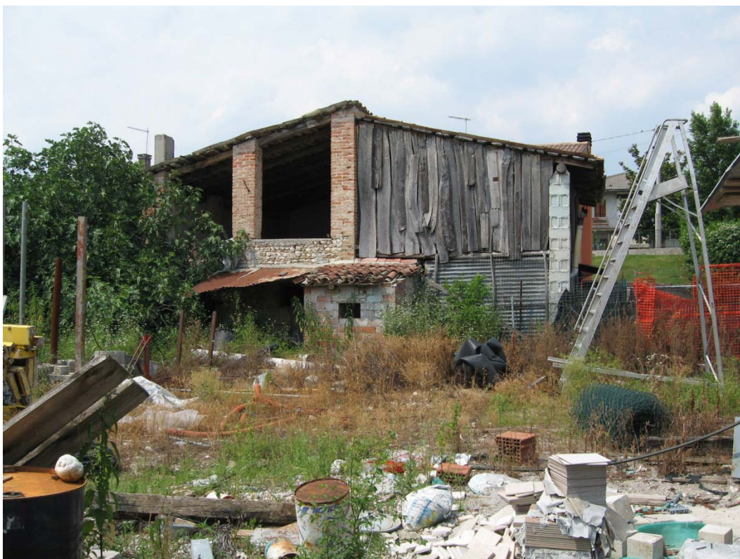
Foto 5: vista sud fabbricato esistente da demolire
