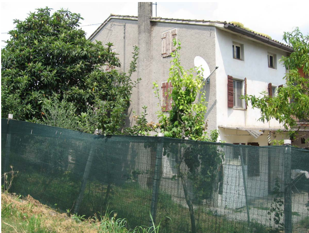
Foto 3: vista sud fabbricato esistente da demolire
