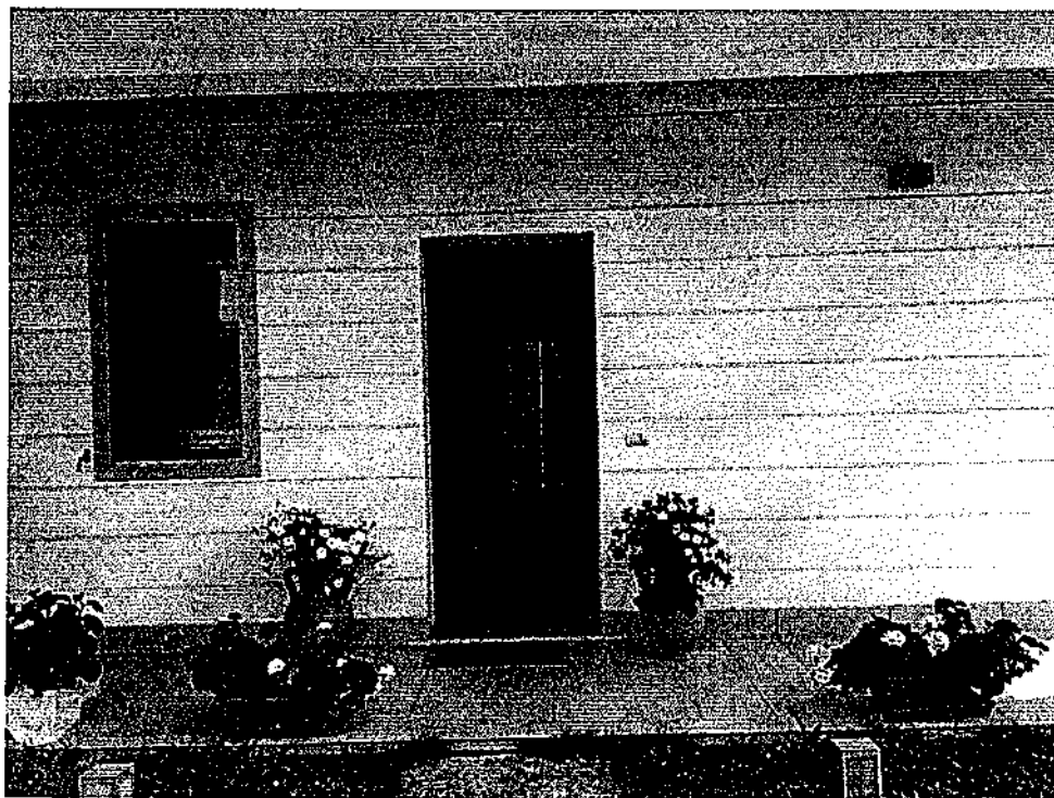
Foto 05: PROSPETTO - lato nord
