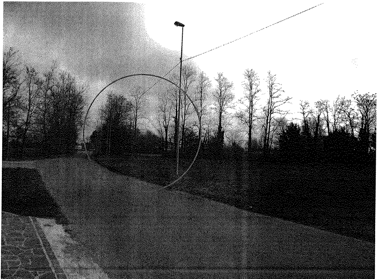
Foto 8 – ubicazione cabina ENEL
