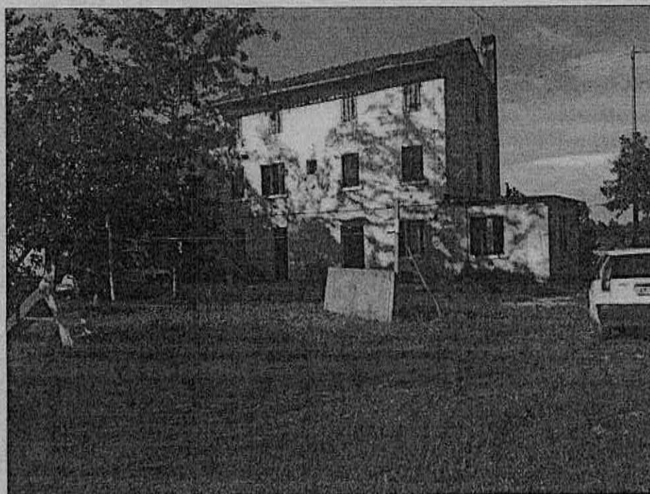
Foto n. 4: Prospetto sud - ovest dell'abitazione
