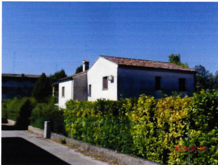
prospetto Sud-Est del fabbricato
