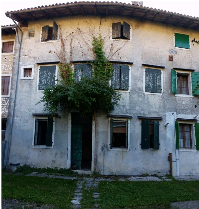
Foto 2 Vista esterna sud lato corte
