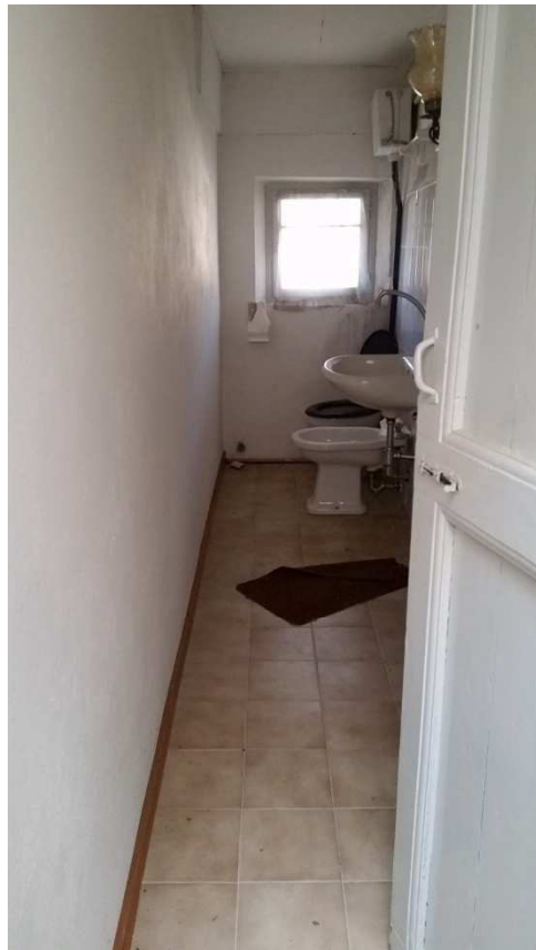
Foto 32 Bagno secondo piano
