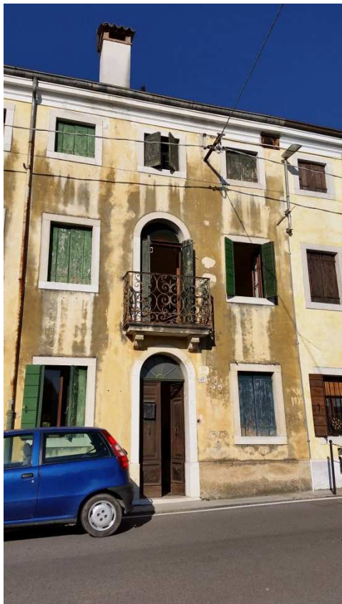
Foto 1 Vista esterna nord da Via Cardazzo
