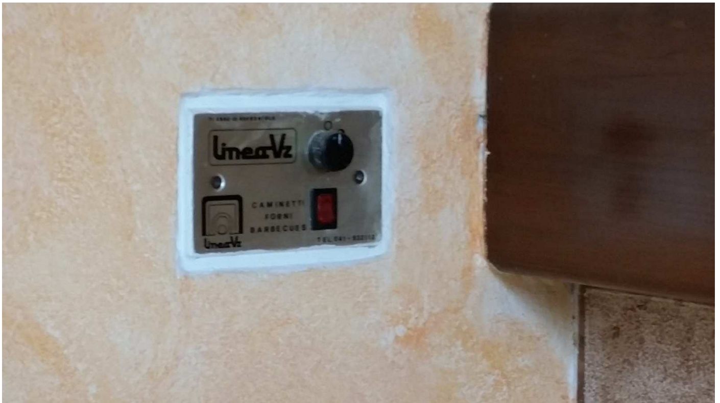
Foto 39 Dettaglio sistema di ventilazione camino
