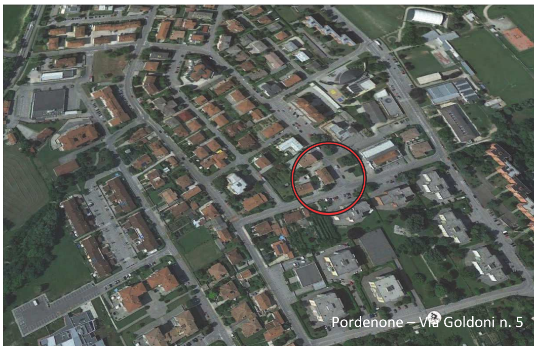
FOTO AEREA – Individuazione Fabbricato
