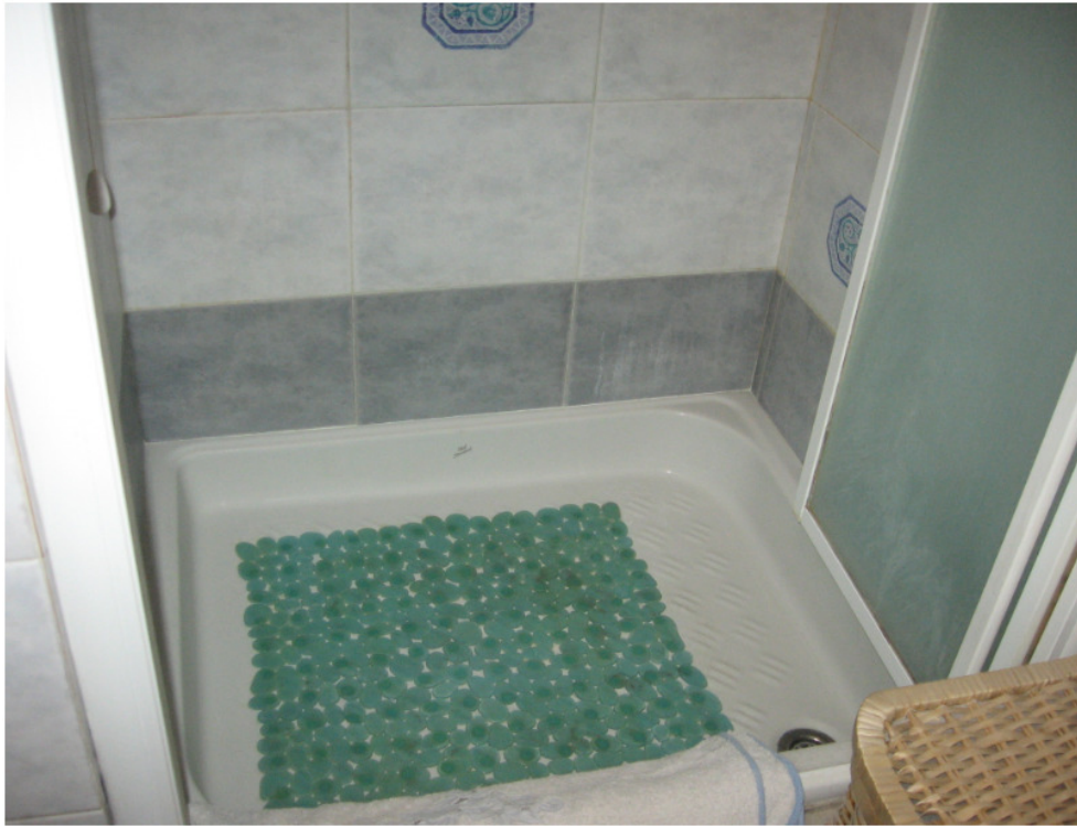
Particolare del piatto doccia del bagno al quinto piano
