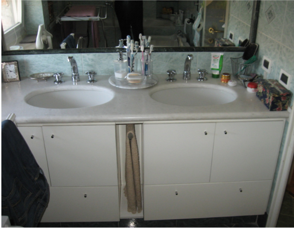
Particolare del lavabi del bagno al sesto piano
