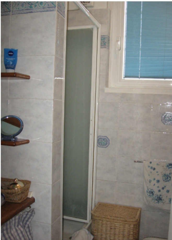
Particolare del box doccia del bagno al quinto piano
