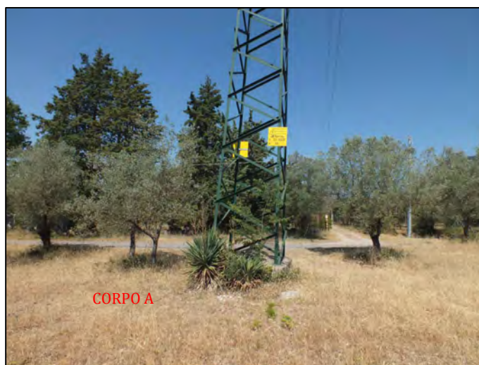
Foto n.ro 16 Vista Sostegno Elettrodotto
