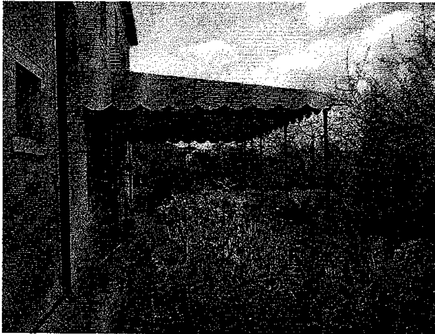
Lato Nord : Vista su portico non autorizzato
