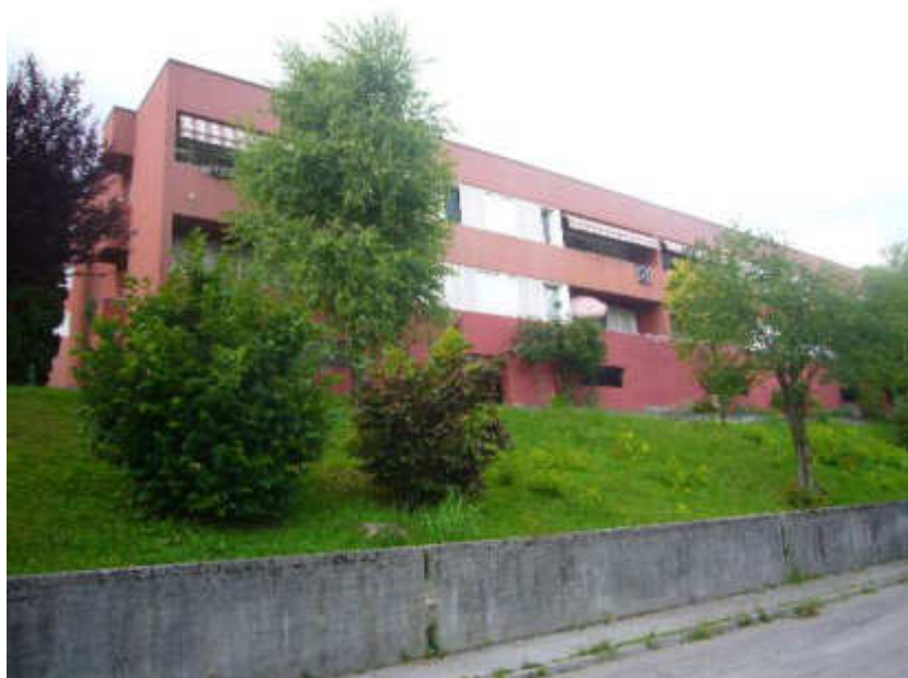
VISTA LATO ESTERNO SUD
