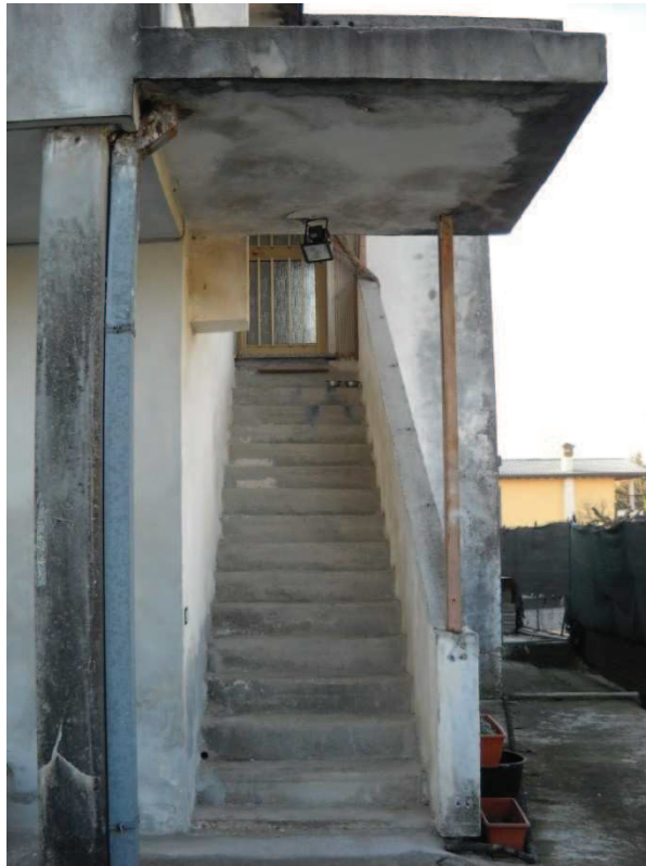
Foto 29 accesso abitazione Piano 1
