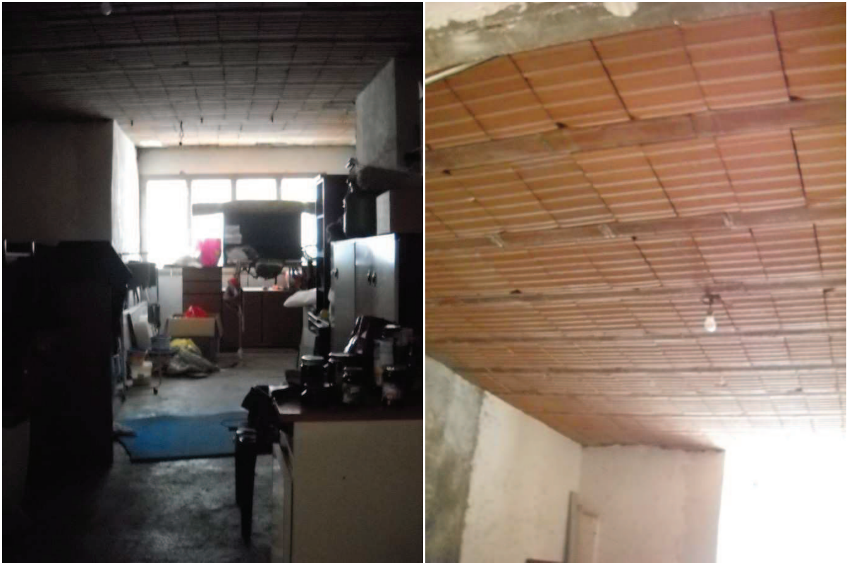
Foto 44-45 garage e particolare soffitto
