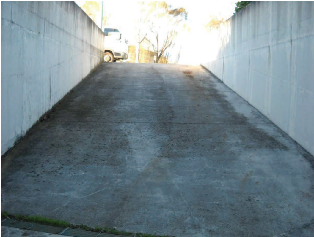
Foto3 Vista accesso immobile esecutato attraverso rampa cementata
