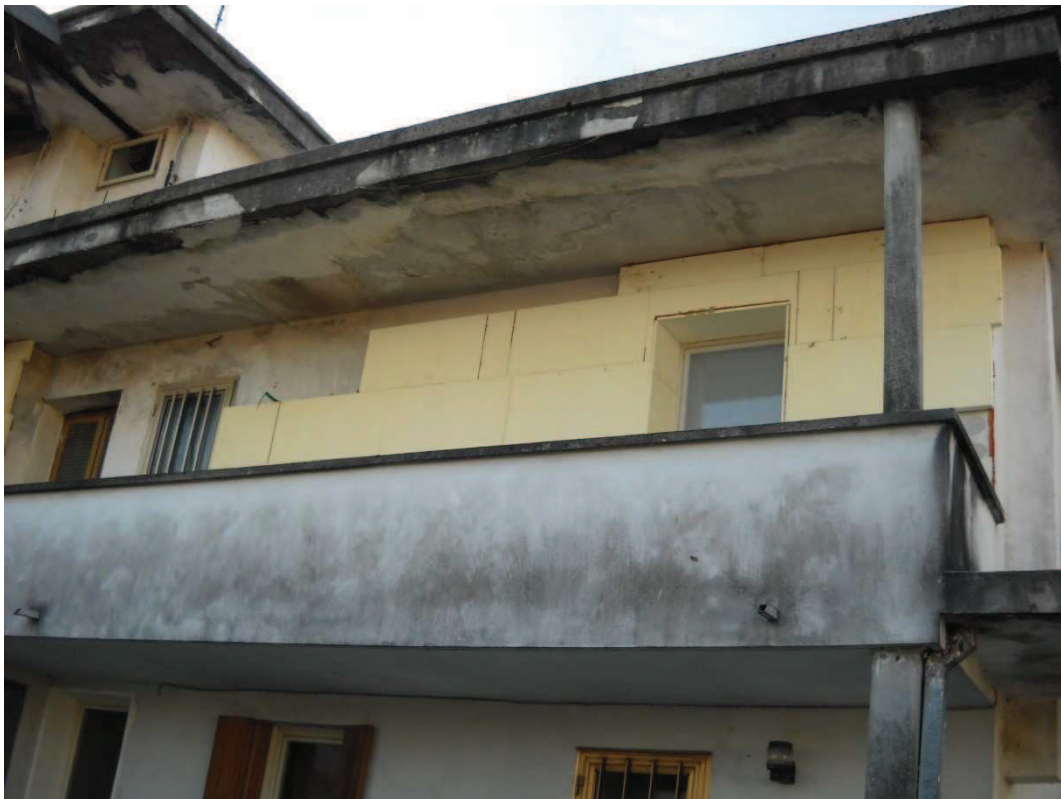
Foto 11 Stato lavori per realizzazione cappotto esterno
