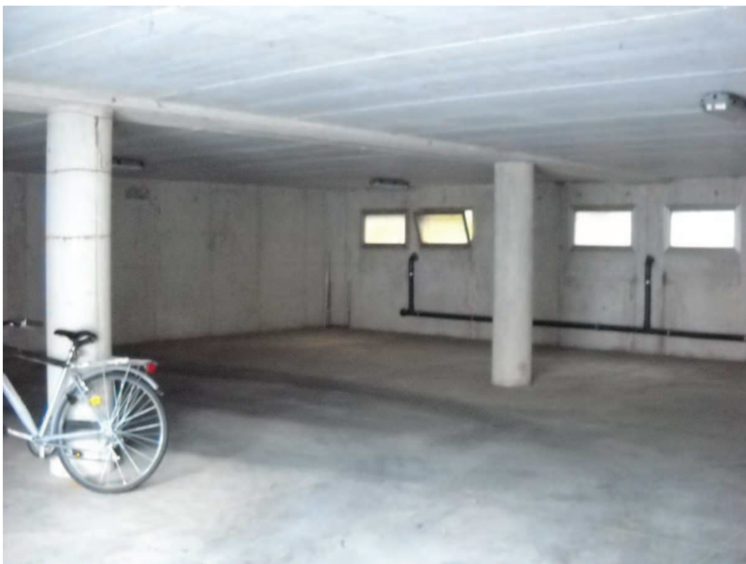
Foto 6 Vista interno magazzino
