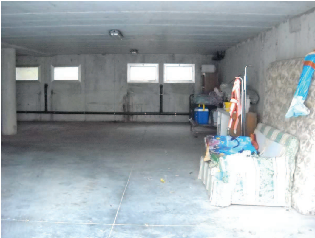
Foto 5 Vista interno magazzino
