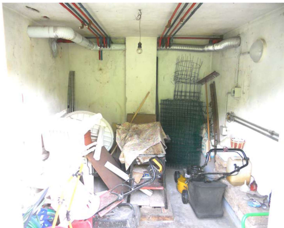
FOTO 28: vista ex centrale termica
