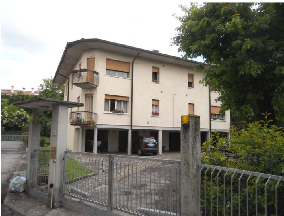
FOTO 1: vista prospetto esterno – strada ingresso dei condomini
