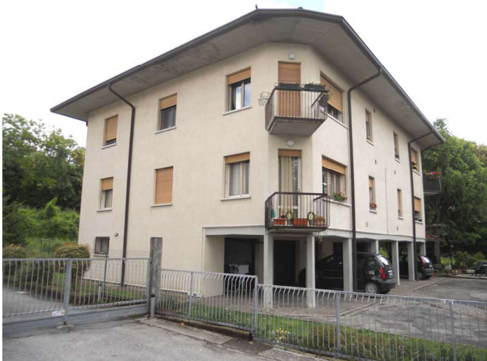
FOTO 2: vista prospetto esterno del condominio
