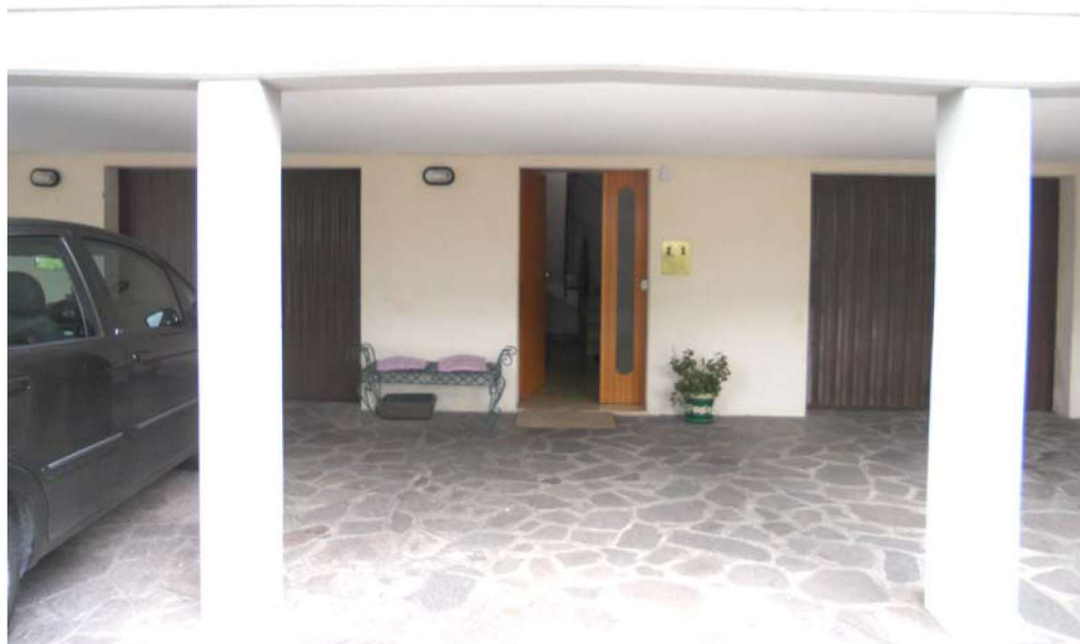
FOTO 6: vista ingresso vano scale comune
