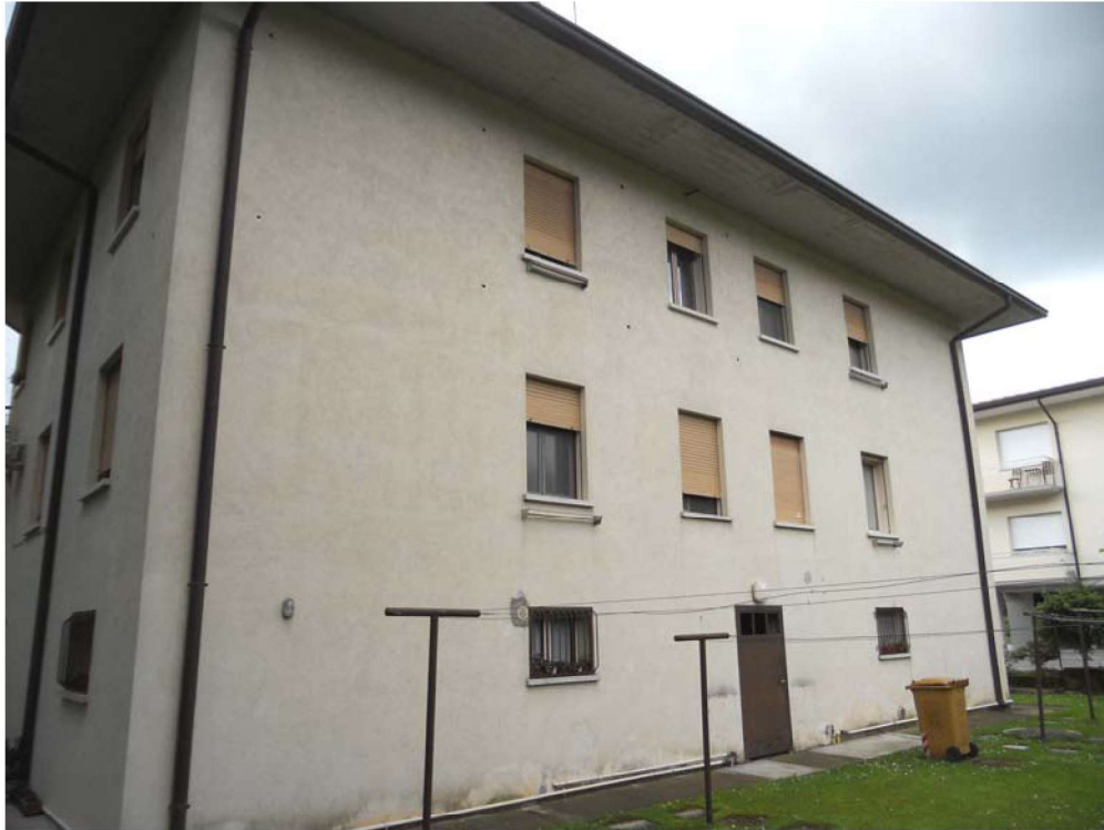
FOTO 3: vista prospetto esterno del condominio
