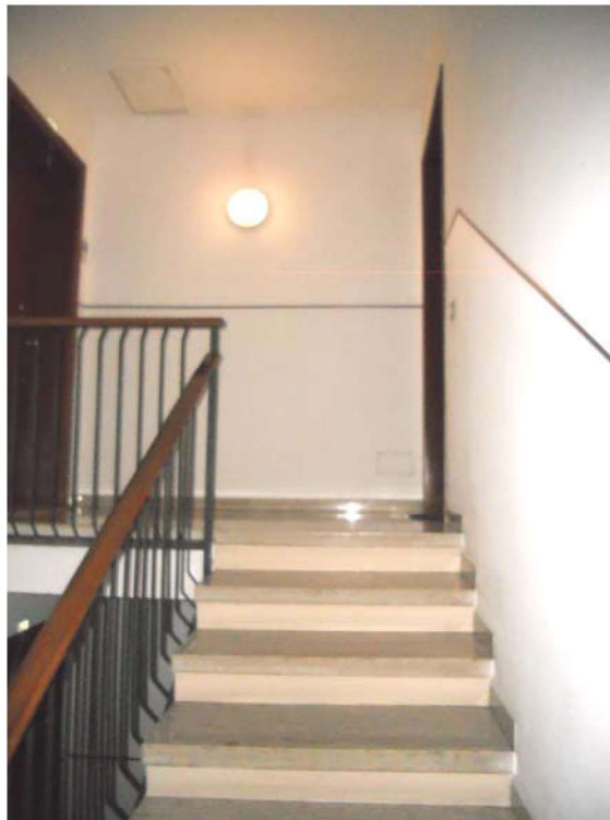
FOTO 8: vista corridoio- porta ingresso
