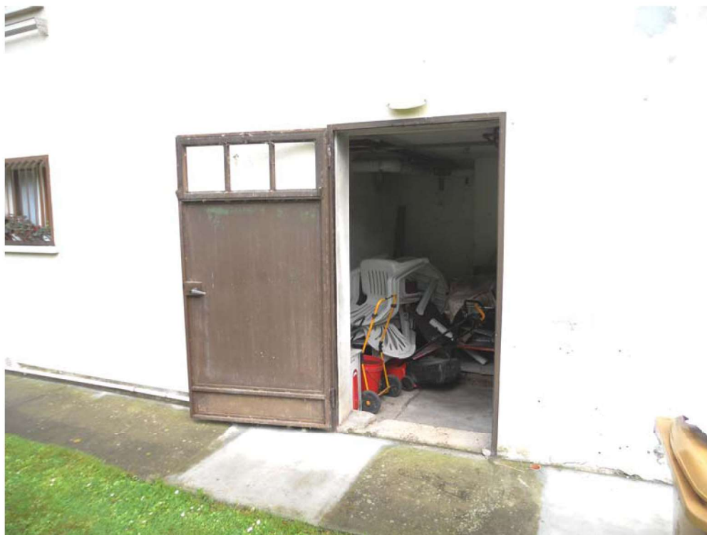
FOTO 27: vista ingresso ex centrale termica
